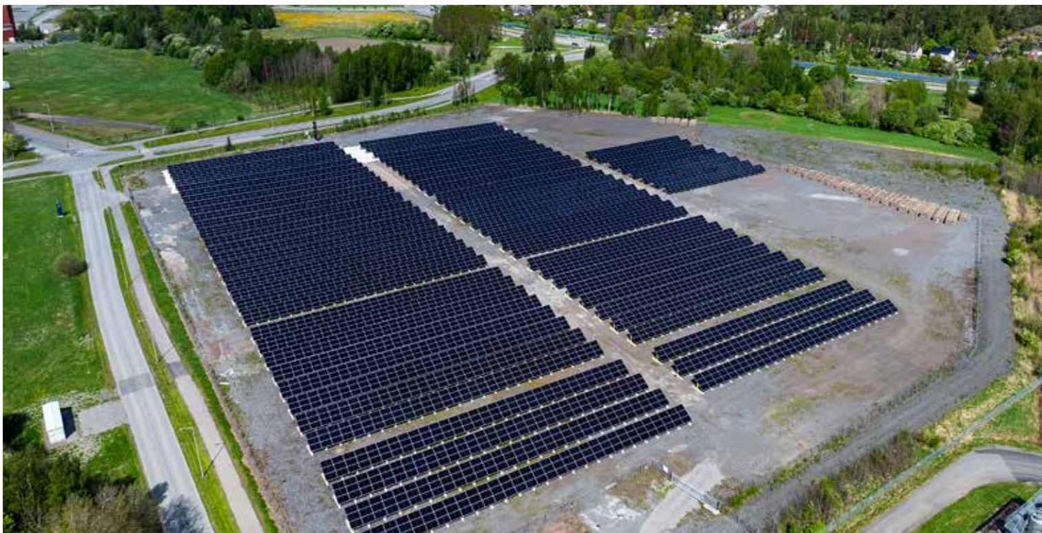
Turku Energian Artukaisten aurinkovoimala koostuu 6 720 aurinkopaneelista. Noin neljän hehtaarin alueelle rakennetun voimalan arvioitu vuosituotanto on 3 400 MWh.
