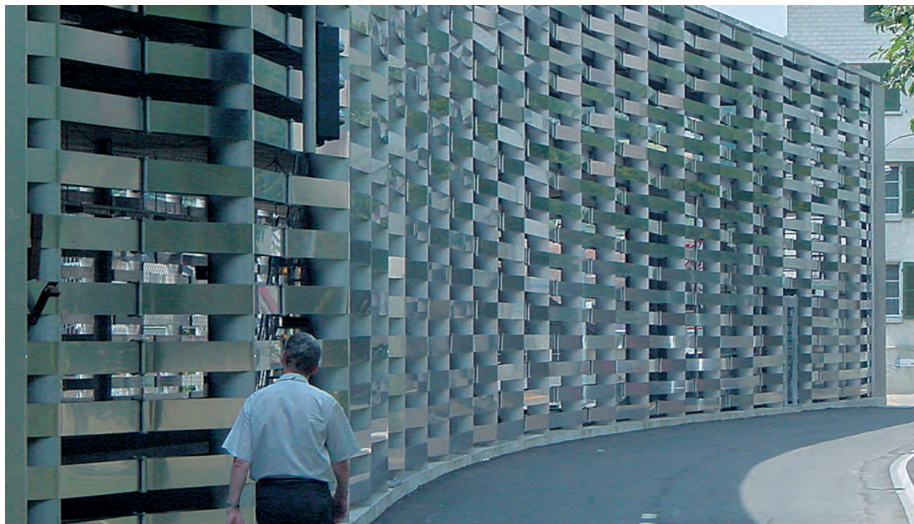
Seitenansicht vom Bahnhof Worb, verwendeter Werkstoff 1.4462
