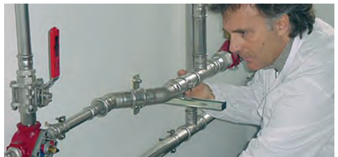
Bild 27 – Kontrolle der Pressverbindung
