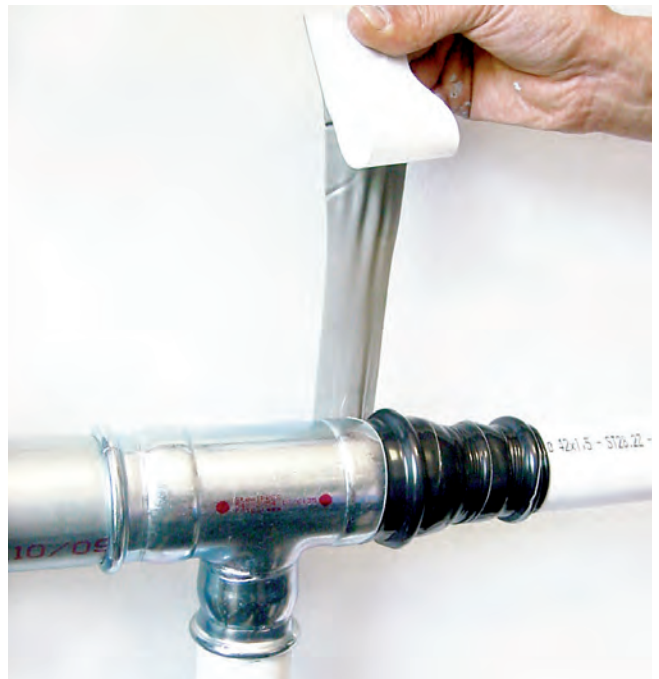
Bild 32 – Schutz der Anschlüsse mit Schutzklebeband
