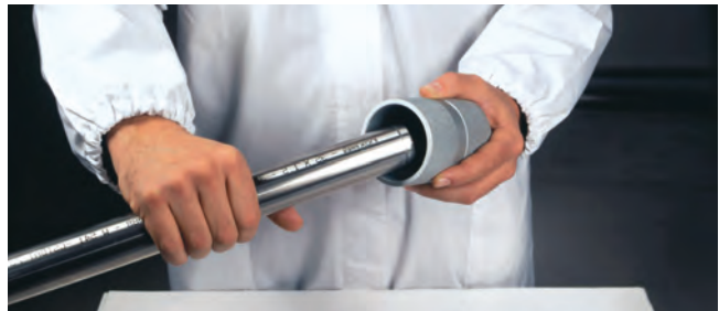
Bild 20 – Entgraten des Leitungsrohres
