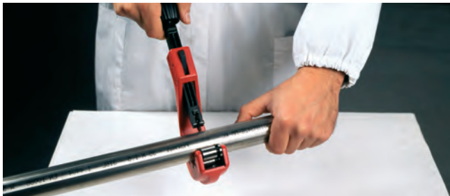
Bild 19 – Ablängen des Leitungsrohres
