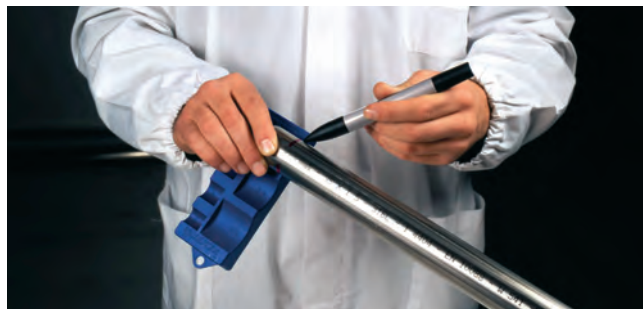
Image 22 – Marquage de la profondeur d'emboîtement
