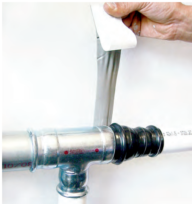
Image 32 – Protection des raccords avec la bande adhésive
