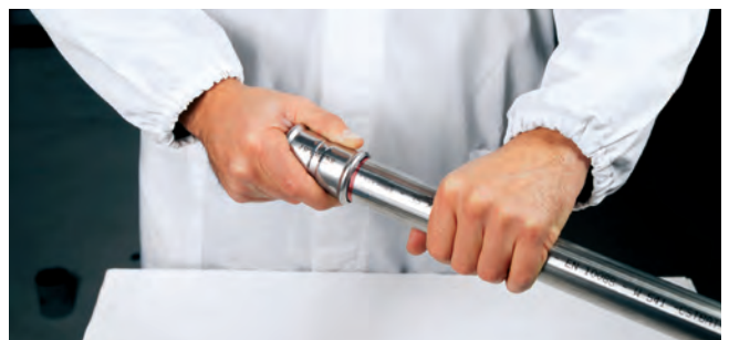
Bild 25 – Einführen des Rohres in den Pressfitting
