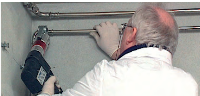
Bild 26 – Herstellen der Pressverbindung
