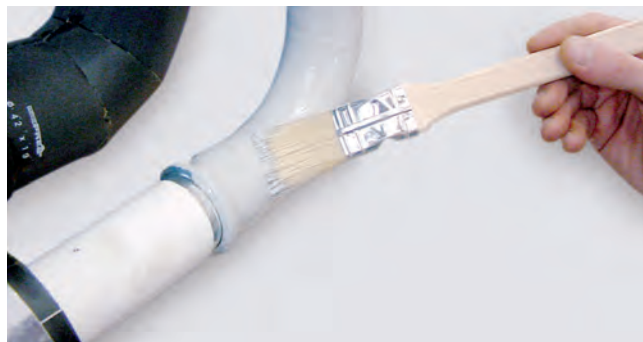
Image 31 – Application du vernis primaire sur les conduites
