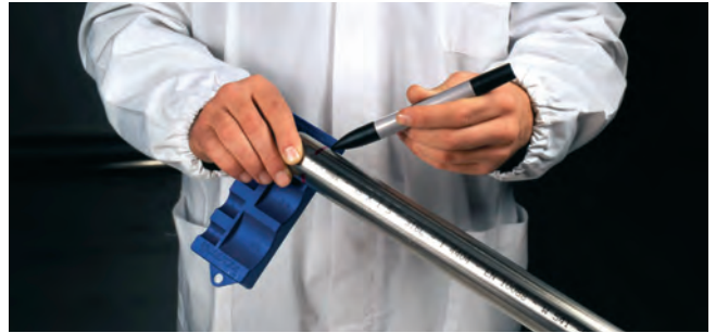
Bild 22 – Markieren der Einstecktiefe
