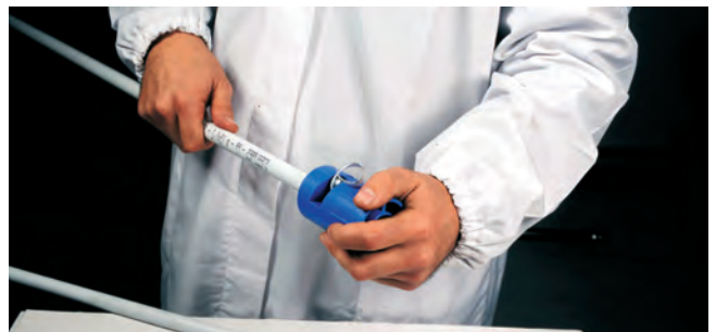
Bild 23 – Abmanteln (steelPRES®)
