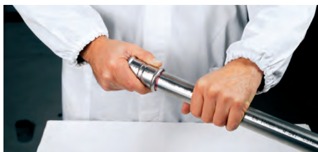
Image 25 – Introduction du tube dans le raccord
