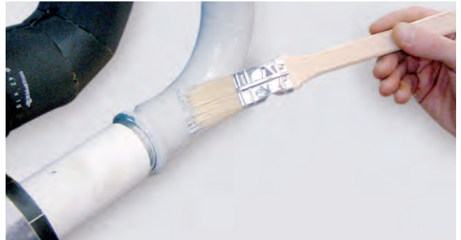
Bild 31 – Lackierung der Anschlüsse und Rohre mit Grundierung
