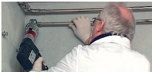
Image 26 – Réalisation du sertissage
