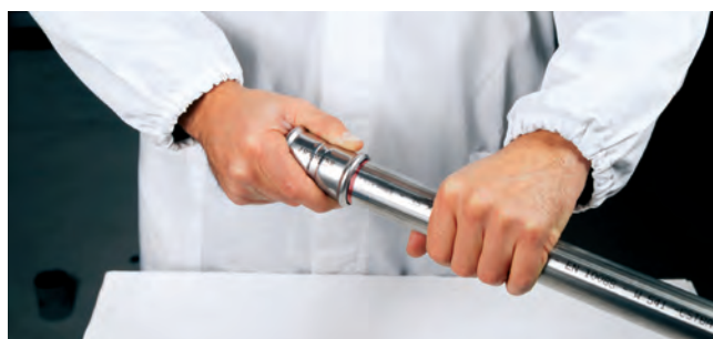
Image 25 – Introduction du tube dans le raccord
