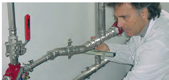
Image 27 – Vérification du sertissage
