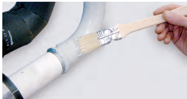
Bild 31 – Lackierung der Anschlüsse und Rohre mit Grundierung
