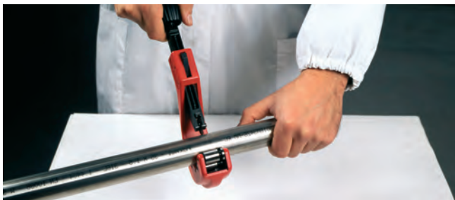
Bild 19 – Ablängen des Leitungsrohres
