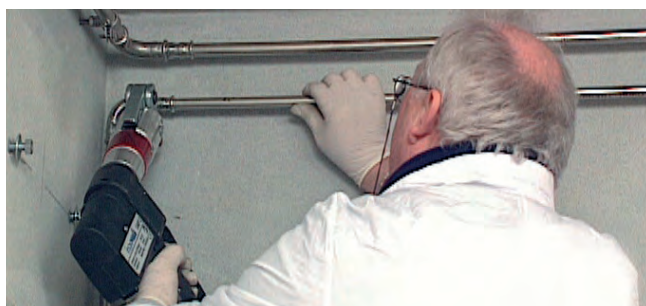
Image 26 – Réalisation du sertissage
