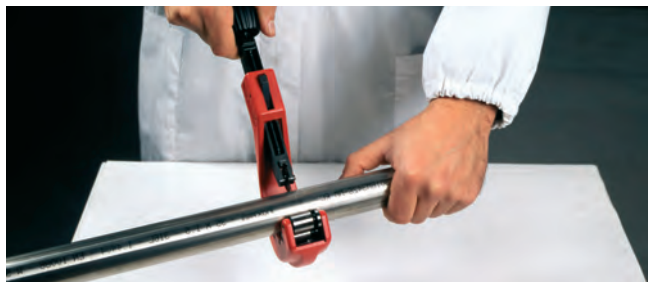
Image 19 – Mise en longueur des tubes
