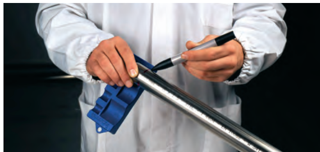
Image 22 – Marquage de la profondeur d'emboîtement
