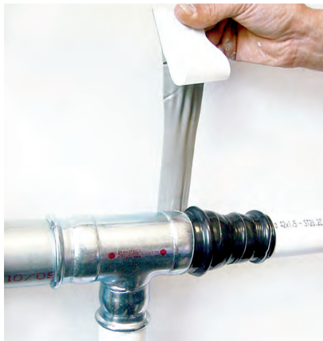
Bild 32 – Schutz der Anschlüsse mit Schutzklebeband
