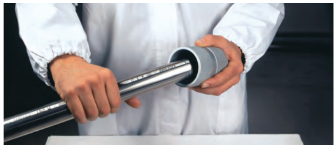
Bild 20 – Entgraten des Leitungsrohres
