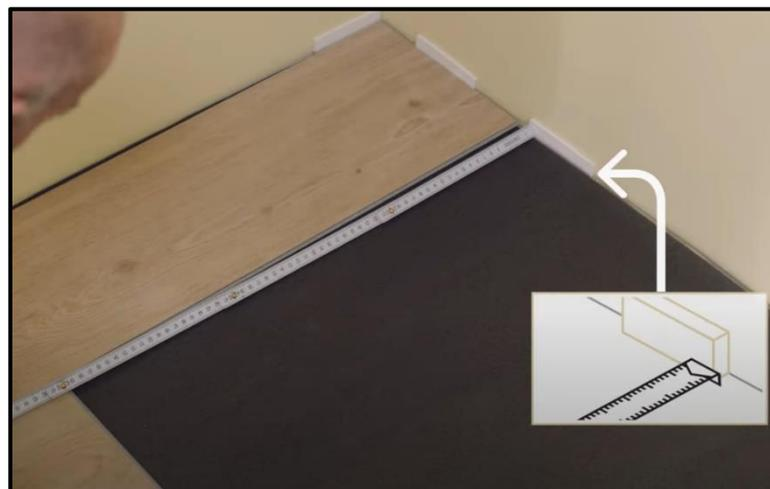
7. Ab der dritten Reihe werden die Planken reihenweise verlegt. Achten Sie darauf, dass Sie genügend Abstandshalter in den Dehnungsfugen anbringen, damit sich der Boden nicht verschiebt. Verwenden Sie eine unterschiedliche Mischung von Dekoren und Planken aus verschiedenen Paketen.
