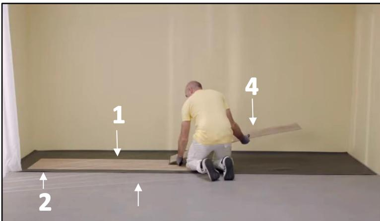
4. Coloque una cuarta lama completa (n°4) en un ángulo de  $30$  grados, en el lado del extremo con el diente en la ranura de la primera lama (n°1) de la primera fila y bájela. Ahora se ve un estrecho espacio entre el tablón n°4 y el tablón n°3. Para ello, levante la tabla n°4 en un ángulo de  $+30$  grados y tire de ella hacia la ranura de la tabla n°3 con el diente.
