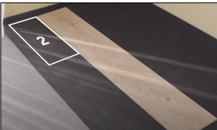
1. Comience con un primer estante completo (n° 1), que se colocará en la esquina superior izquierda de su habitación. Preferiblemente coloque los 2 lados con diente hacia las paredes y asegúrese de que se respete la junta de dilatación de 5 mm. La ranura o el diente no forman parte de la junta de expansión. Si es necesario, córtelo.
