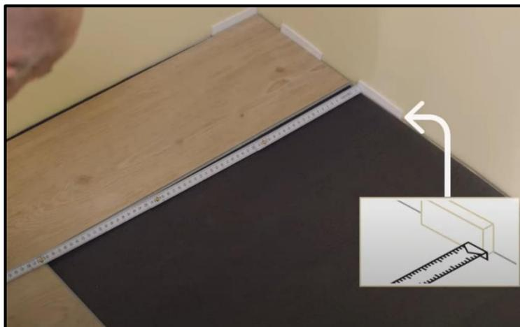
7. A partir de la tercera fila, los lamas se colocan fila por fila. Asegúrese de colocar suficientes espaciadores en las juntas de expansión para que el piso no se mueva. Use una mezcla variada de decoraciones y lamas de diferentes trajes.
