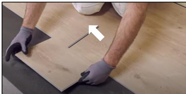
5. Repita las operaciones 3 y 4 hasta llegar al final de las dos primeras filas. A continuación, desliza todo contra la pared. Utilice espaciadores
