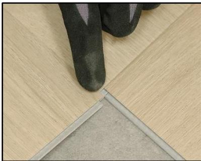
**TIPP:** Verwenden Sie eine zweite L-Planke und legen Sie sie ein paar Millimeter über die Kante. Auf diese Weise können Sie die R-Planke in die richtige Position schieben und alles wird schön ausgerichtet.
