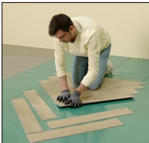
4. Klicken Sie dann abwechselnd linke und rechte Planken an das Ausgangsdreieck und bauen Sie auf diese Weise. Achte immer darauf, dass die Nähte gut zusammenpassen!
