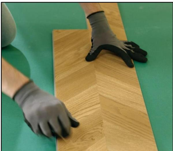
1. Commencez par une première planche A (ou B) complète, qui se trouve dans le coin supérieur gauche de votre pièce. Posez de préférence les 2 côtés avec la languette vers les murs et veillez à ce que le joint de dilatation de 5 mm soit respecté. La rainure ou la languette ne fait pas partie du joint de dilatation. Coupez-les si nécessaire.
