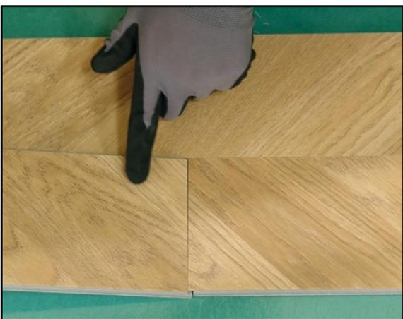
5. Placez la planche coupée du côté de l'extrémité avec la languette dans la rainure à un angle de  $\pm 30$  degrés et abaissez-la.
