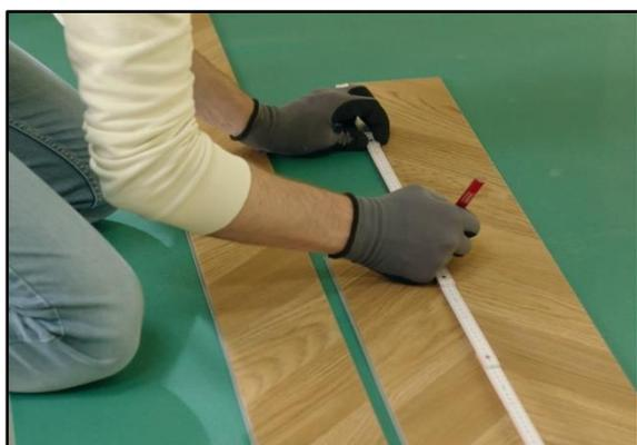
3. Mesurez la distance entre le côté court de la deuxième planche et l'extrémité de la première planche ou le mur de gauche. Tenez compte du joint de dilatation de 5 mm.
