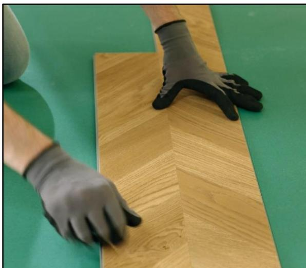
1. Comience con una primera lama completo A (o B), que estará en la esquina superior izquierda de su habitación. Preferiblemente coloque los 2 lados con diente hacia las paredes y asegúrese de que se respete la junta de dilatación de 5 mm. La ranura o el diente no forman parte de la junta de expansión. Córtalos si es necesario.
