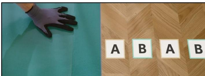
8. A partir la tercera fila, los tablonos se colocan fila por fila. Asegúrese de colocar suficientes espaciadores en las juntas de expansión para que el piso no se mueva. Usa una mezcla variada de decorados y tablonos de diferentes trajes. En cada fila hay todos los tablonos A o todos los tablonos B. Cada fila alterna entre A y B.
