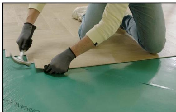
**ASTUCE** : Vous pouvez également insérer les planches horizontalement à l'aide d'un bloc de frappe et d'un marteau. Vous pouvez également utiliser un morceau de sol comme bloc de frappe. Ne frappez jamais directement le système clic! Veillez à ce que le sol soit complètement fixé afin qu'il ne puisse pas bouger !
