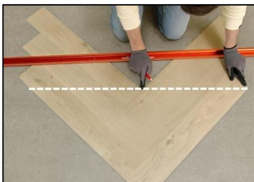
1. Tracez une ligne droite sur le côté décor des planches à partir du coin droit de la dernière planche R installée (troisième planche R) (n° 6) jusqu'au point central supérieur du triangle.
