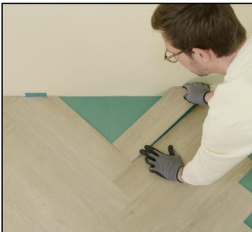
11. Remplissez les triangles ouverts contre le mur en utilisant la même technique. C'est ici qu'un tire-lame de remorquage s'avère très utile, car les planches sont de plus en plus petites !
