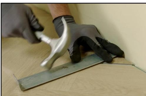
12. Vous pouvez utiliser une fausse équerre pour déterminer l'angle correct. Veillez à respecter le joint de dilatation de 5 mm !
