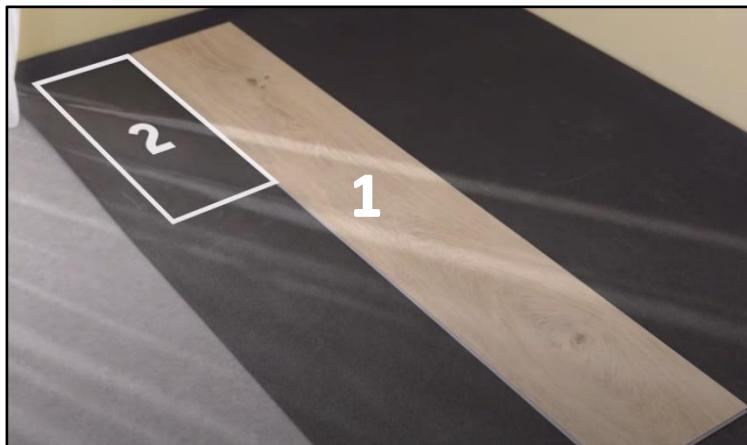
1. Commencez par une première planche complète (n°1), qui se trouve dans le coin supérieur gauche de votre pièce. Posez de préférence les 2 côtés avec la languette vers les murs et veillez à ce que le joint de dilatation de 5 mm soit respecté. La rainure ou la languette ne fait pas partie du joint de dilatation. Coupez-les si nécessaire.
