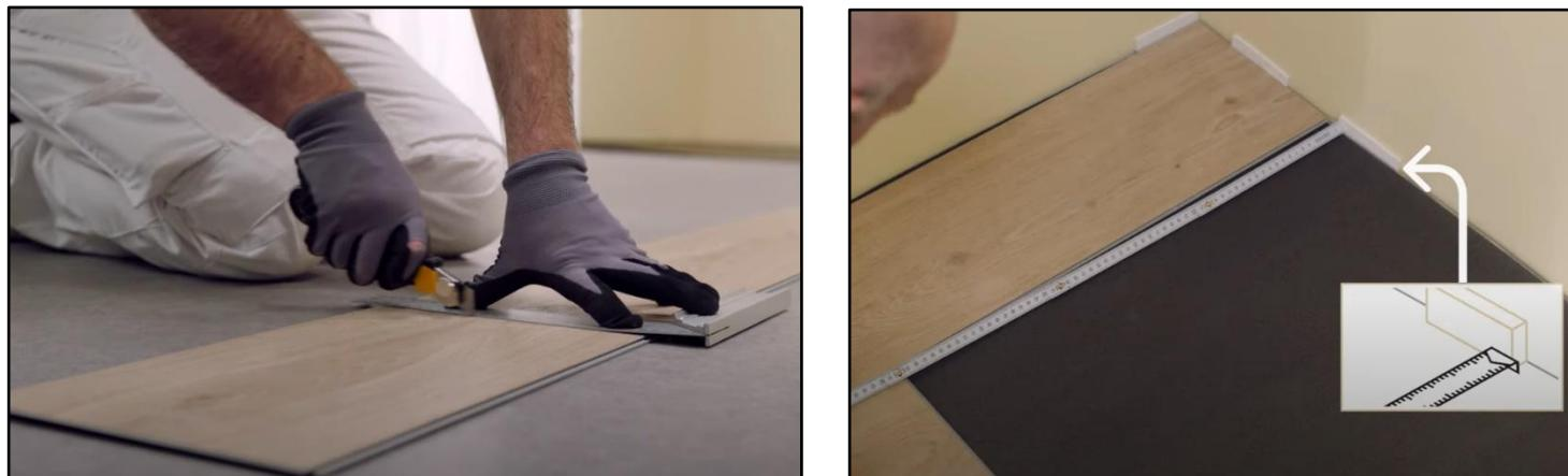
7. À partir de la troisième rangée, placez les planches rangée par rangée. Veillez à placer suffisamment de cales dans les joints de dilatation pour que le sol ne se déplace pas. Utilisez un mélange varié de décors et de planches provenant de différents paquets.
