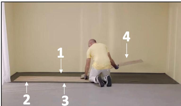
4. Placez une quatrième planche complète (n°4), avec un angle de  $\pm 30$  degrés, du côté de la tête avec la languette dans la rainure de la première planche (n°1) de la première rangée et abaissez-la. Un espace étroit est maintenant visible entre la planche n°4 et la planche n°3. Pour ce faire, soulever la planche n°4 à un angle de  $\pm 30$  degrés et la tirer avec la languette dans la rainure de la planche n°3.
