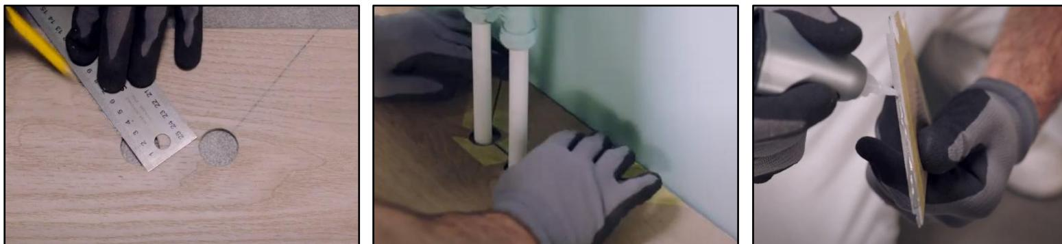
Dans le cas d'un double tuyau, percez un trou du même diamètre que les tuyaux à tous les points marqués, en rajoutant 15 mm. Si les tuyaux sont sur le long côté de la planche, faites une coupe à 45 degrés de chaque trou vers le côté de la planche.
