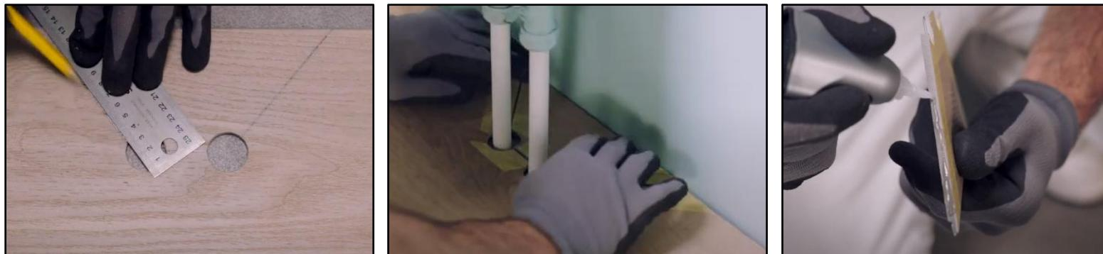
Dans le cas d'un double tuyau, percez un trou du même diamètre que les tuyaux à tous les points marqués, en rajoutant 15 mm. Si les tuyaux sont sur le long côté de la dalle, faites une coupe à 45 degrés de chaque trou vers le côté de la dalle.
