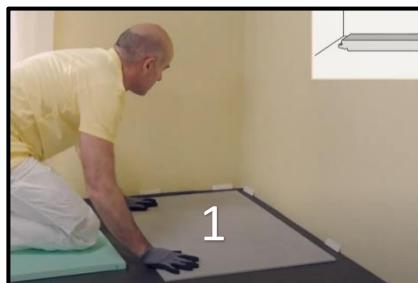
1. Commencez par une première dalle entière (n°1), qui sera placée dans le coin supérieur gauche de votre pièce. Posez de préférence les 2 côtés avec la languette vers les murs et veillez à ce que le joint de dilatation de 5 mm soit respecté. La rainure ou la languette ne fait pas partie du joint de dilatation. Coupez-les si nécessaire.
