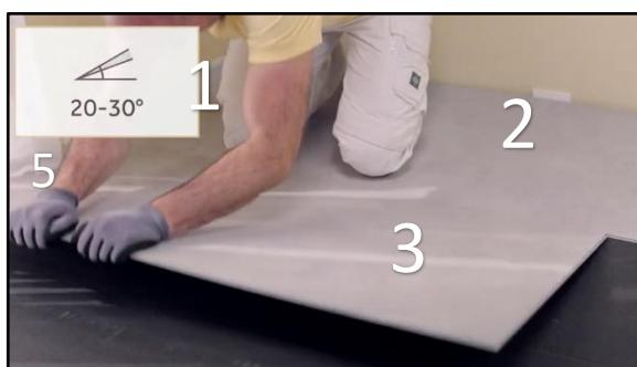
3. Une petite ouverture est maintenant visible entre les dalles de la première rangée (n°1 & 2) et celles de la deuxième rangée (n°3). Soulevez la dalle (n°3) à un angle de  $\pm 30$  degrés et tirez-la avec la dent dans la rainure des 1ère et 2ème dalles de la première rangée et abaissez-la. Si nécessaire, tapez dessus avec un morceau de dalle restant ou un bloc de frappe et un marteau en caoutchouc jusqu'à ce que le joint entre les carreaux soit complètement fermé.
