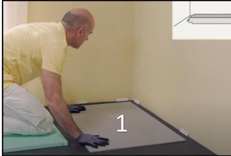
1. Beginnen Sie mit einer ersten, vollständigen Fliese (Nr. 1), die in der oberen linken Ecke Ihres Raumes platziert wird. Verlegen Sie die beiden Seiten vorzugsweise mit der Feder zu den Wänden und achten Sie darauf, dass die Dehnungsfuge von 5 mm eingehalten wird. Die Nut oder Feder ist nicht Teil der Dehnungsfuge. Schneiden Sie sie nötigenfalls ab.
