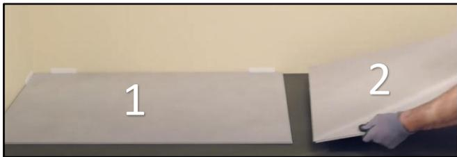
2. Nehmen Sie eine zweite, vollständige Fliese (Nr. 2) und klicken Sie sie in einem Winkel von  $\pm 30$  Grad in die kurze Seite der ersten Fliese (Nr. 1). Achten Sie darauf, dass sie in einer geraden Linie zueinander stehen. Halten Sie beim Verlegen aller Fliesen  $\pm 30$  Grad ein! Dadurch wird die Installation wesentlich erleichtert.
