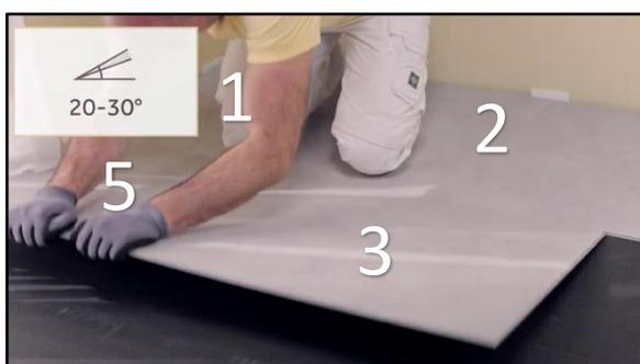
3. Zwischen den Fliesen der ersten Reihe (Nr. 1 und 2) und denen der zweiten Reihe (Nr. 3) ist nun ein schmaler Spalt sichtbar. Heben Sie die Fliese (Nr. 3) in einem Winkel von  $\pm 30$  Grad an und ziehen Sie sie mit der Feder in die Nut der ersten und zweiten Fliese der ersten Reihe und senken Sie sie ab. Klopfen Sie gegebenenfalls mit einem Fliesenrest oder einem Schlagklotz und einem Gummihammer, bis die Fuge zwischen den Fliesen vollständig geschlossen ist.
