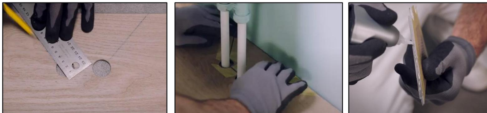
Bei einem Doppelrohr bohren Sie an allen markierten Stellen ein Loch mit demselben Durchmesser wie die Rohre, wobei Sie 15 mm abzählen. Wenn sich die Rohre an der Längsseite der Planken befinden, machen Sie einen 45-Grad-Schnitt von jedem Loch zur Seite der Planke.
