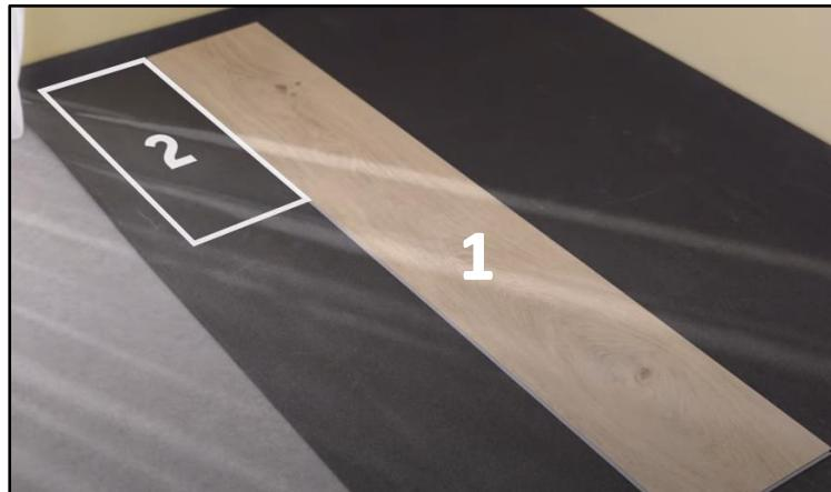
1. Beginnen Sie mit der ersten, vollständigen Planke (Nr. 1), die sich in der linken oberen Ecke des Raumes befindet. Verlegen Sie die beiden Seiten vorzugsweise mit der Feder zu den Wänden und achten Sie darauf, dass die Dehnungsfuge von 5 mm eingehalten wird. Die Nut oder Feder ist nicht Teil der Dehnungsfuge. Schneiden Sie sie nötigenfalls ab.
