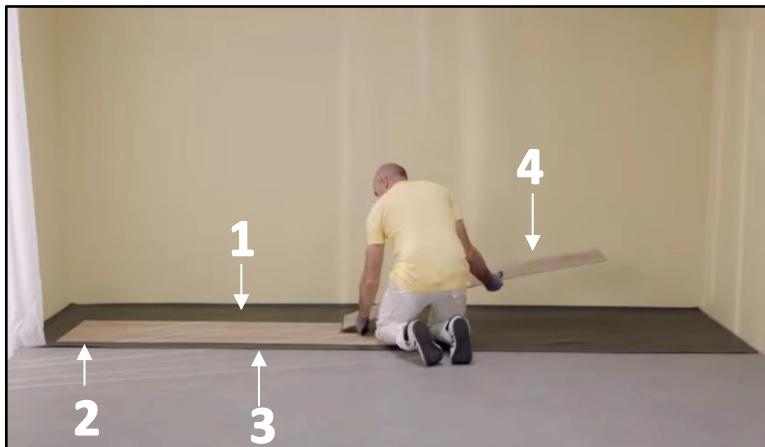
4. Legen Sie eine vierte komplettes Planke (Nr. 4) in einem Winkel von +30 Grad an der Kopfseite mit der Feder in die Nut der ersten Planke (Nr. 1) der ersten Reihe und senken Sie es ab. Zwischen Planke Nr. 4 und Planke Nr. 3 ist nun ein schmaler Spalt sichtbar. Dazu heben Sie die Planke Nr. 4 in einem Winkel von +30 Grad an und ziehen es mit der Feder in die Nut des Brettes Nr. 3.
