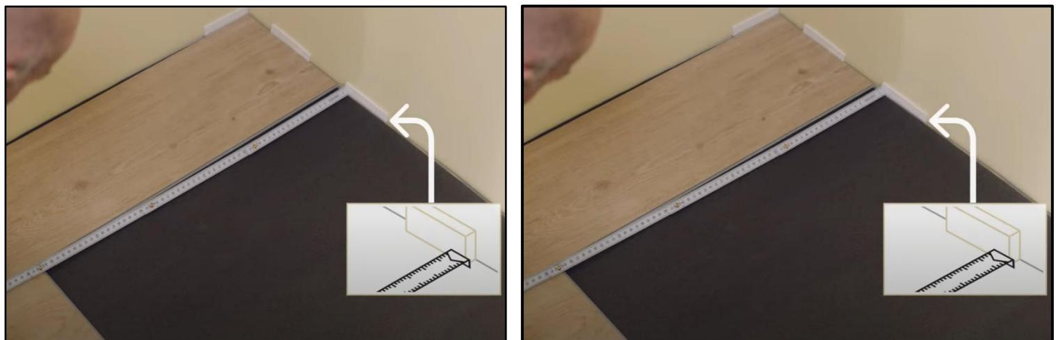
7. Ab der dritten Reihe werden die Planken reihenweise verlegt. Achten Sie darauf, dass Sie genügend Abstandhalter in den Dehnungsfugen anbringen, damit sich der Boden nicht verschiebt. Verwenden Sie eine unterschiedliche Mischung von Dekoren und Planken aus verschiedenen Paketen.
