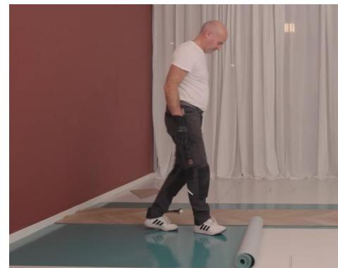
Die erste Planke der dritten Reihe muss noch einmal zugeschnitten werden. Messen Sie den genauen Abstand, den Sie benötigen, um sicherzustellen, dass das Muster genau übereinstimmt. Denken Sie auch daran, dass eine Mindestversatz von 30 cm mit der Fuge des Paneels der angrenzenden Reihe erforderlich ist. Beachten Sie die mindestens 5mm breite Dehnungsfuge/Wandabstand einzuhalten.
