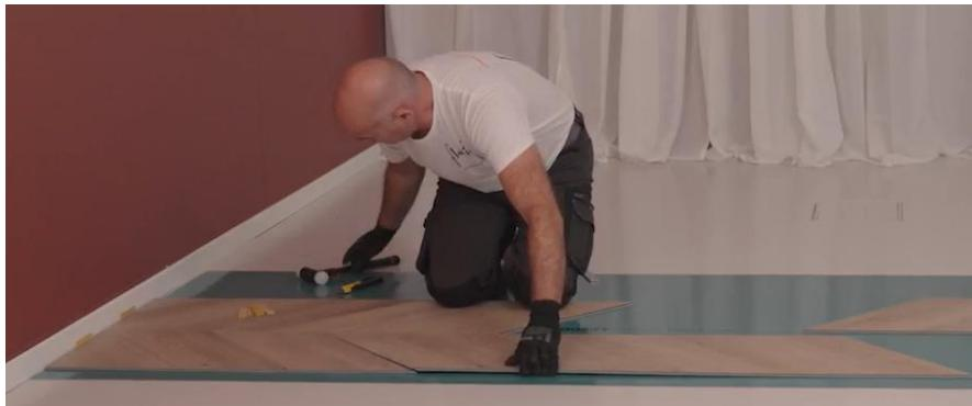
Wiederholen Sie den gleichen Vorgang für die nächste Reihe. Abwechselnd mit A- und B-Platten arbeiten, um die ersten beiden Reihen zu verlegen. Prüfen Sie immer, ob die Paneele richtig geschlossen sind.
