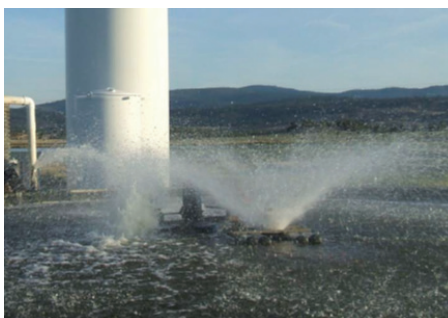
Napowietrzacz natryskowy o wydajności: SAE: 0,06-0,17 kg O 2 /kWh
