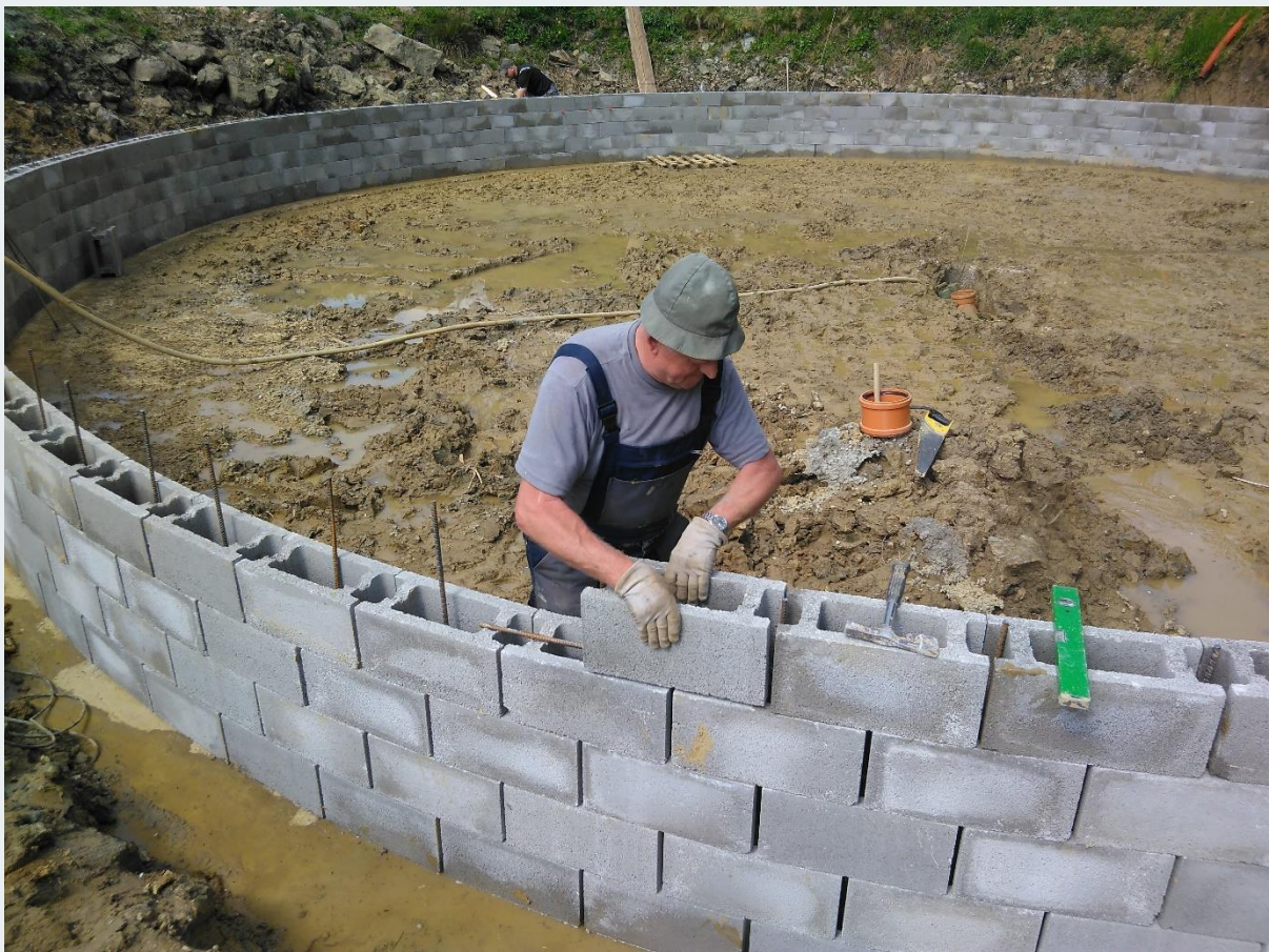
Ryc. 4 Budowa system TBP.
