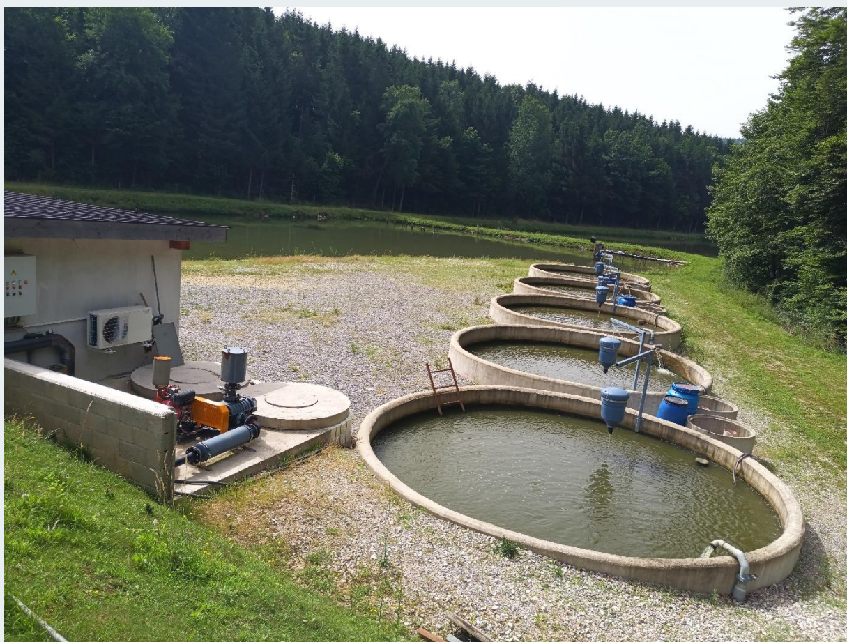
Ryc.3 System TBP ze zbiornikami o średnicy 5 m (hodowla Żabnik (Słowenia), G20 d.o.o.)
