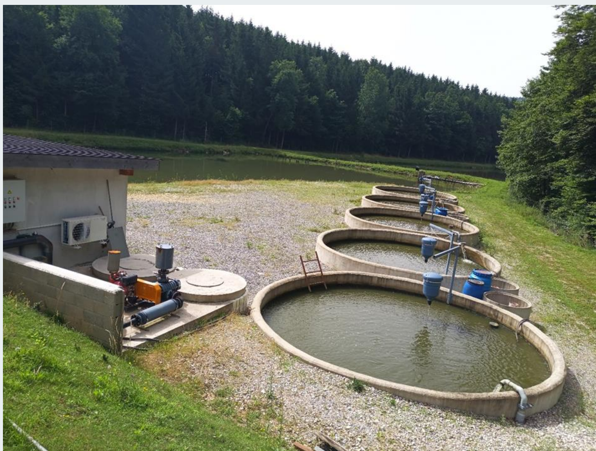
Kép 3. A TBP (Tervezett Biológiai Reaktor) rendszer a 5 méteres átmérőjű medencékkel a Ribogojilište Žabnik, Szlovéniában, a G20 d.o.o. kivitelezésében
