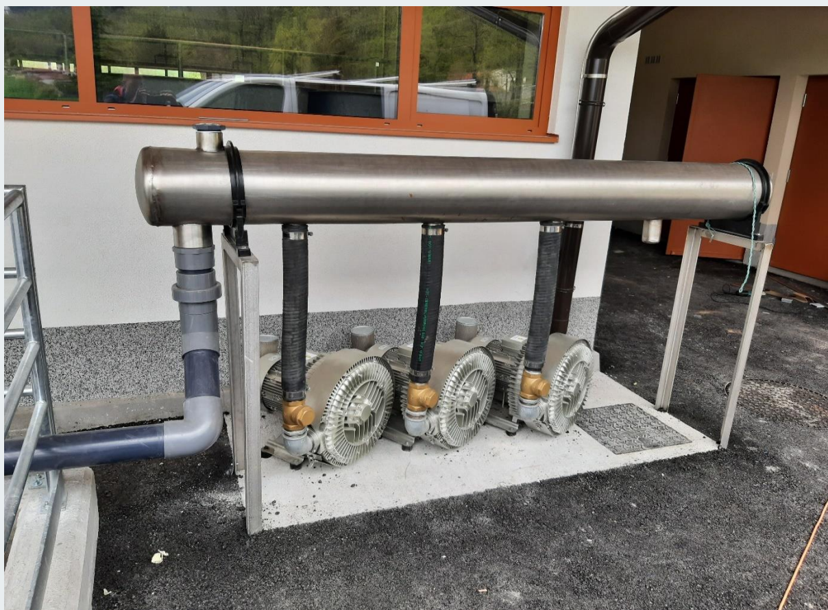
Kép 7. Beépített radiális légfúvók
