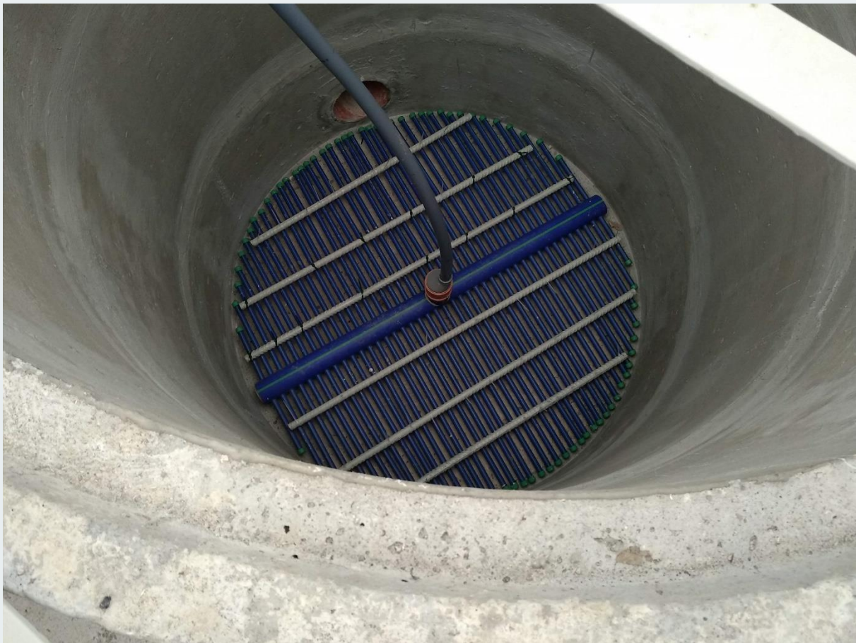
Kép 11. Telepített csöves diffúzor az airliftben
