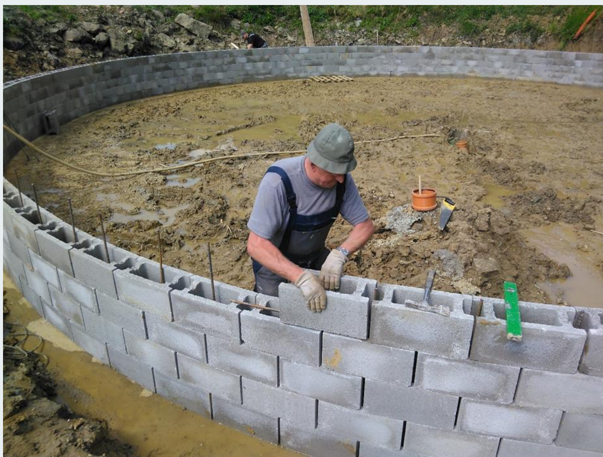
Kép 4.A TBP randszer építése „H„ betonblokkal
