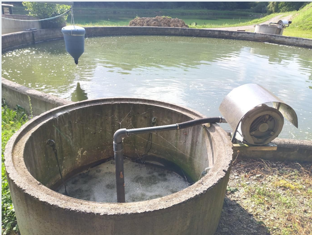
Kép 8. Az egyedi radiális ventilátorok telepítése „Airlift”-nél
