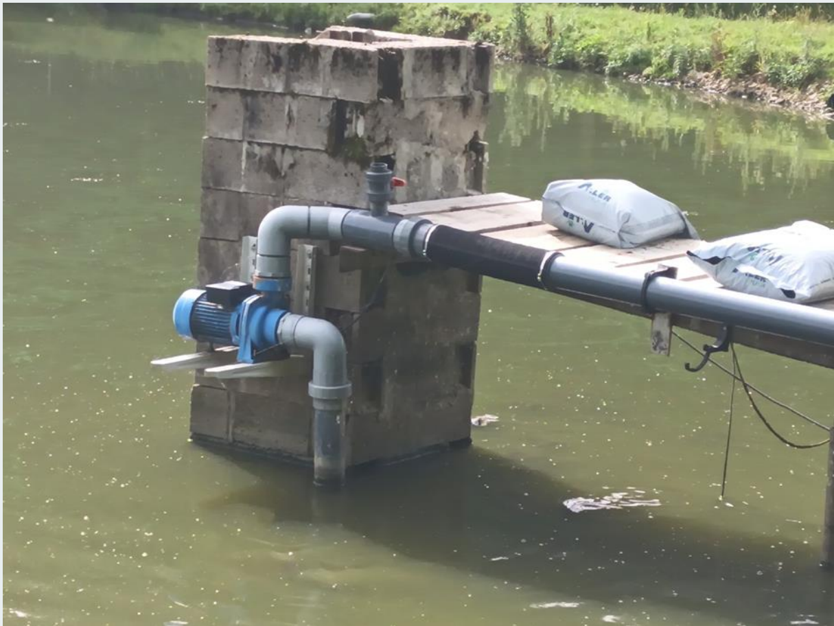
Kép 5. Telepített Vízforgató Szivattyú a TBP Rendszerben
