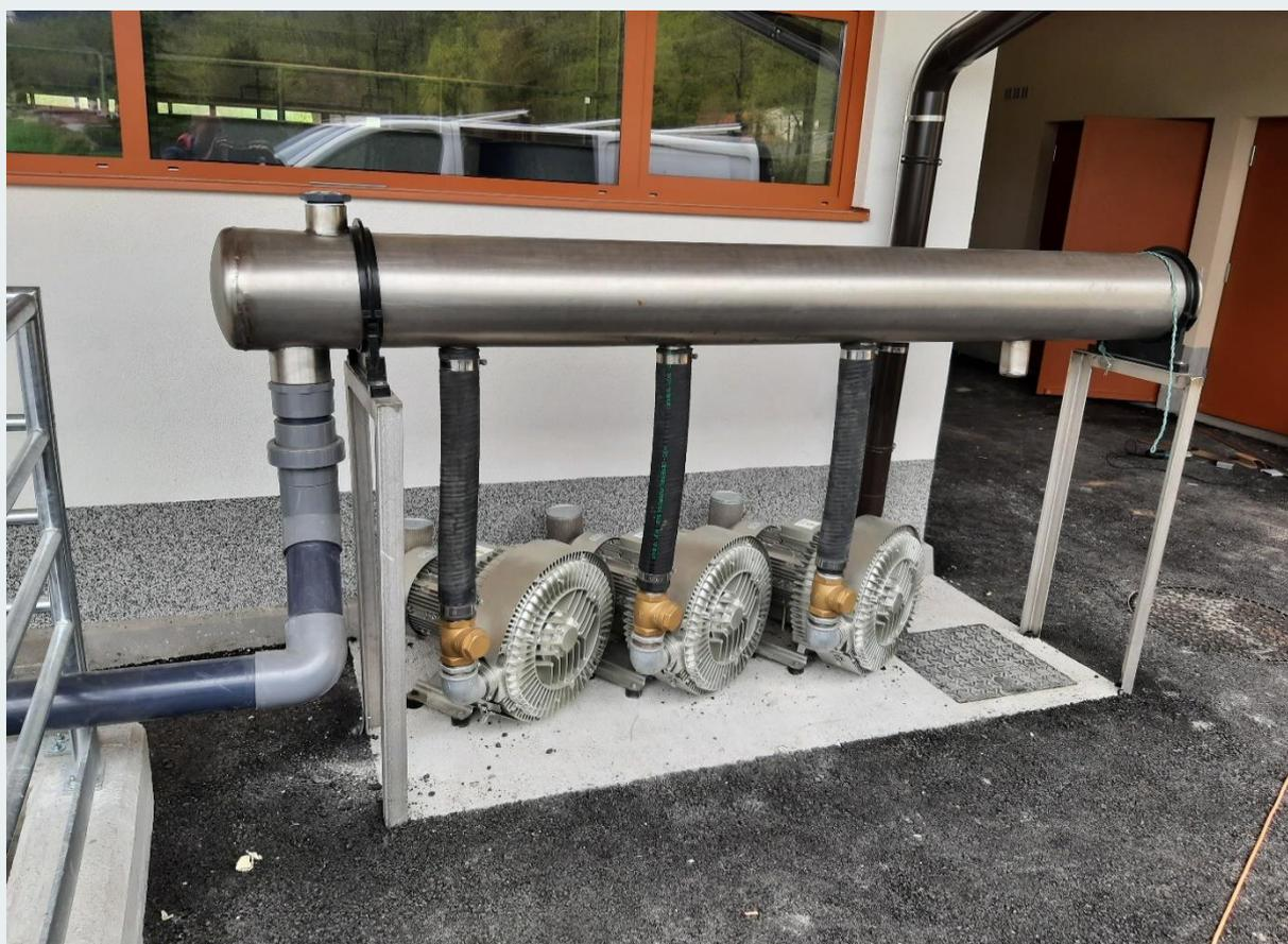
Рис. 7 Центральный блок вихревой воздуходувки
