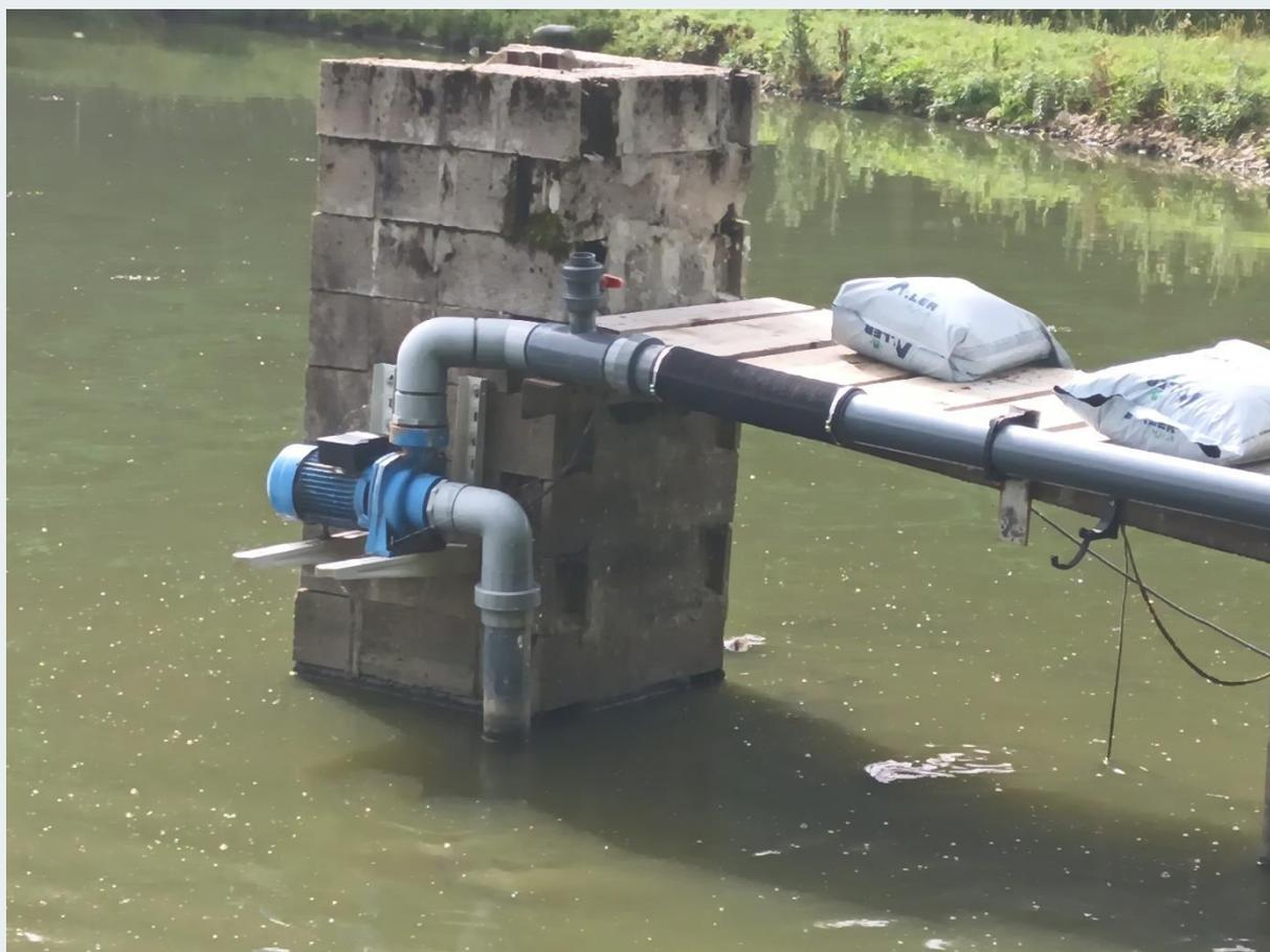
Рис. 5 Насос для подпитки системы ТБП.
