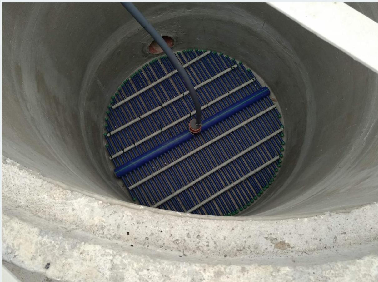
*Рис. 11 Крупнопузырьковый диффузор (трубы с просверленными отверстиями), установленный в отсеке эрлифта*
