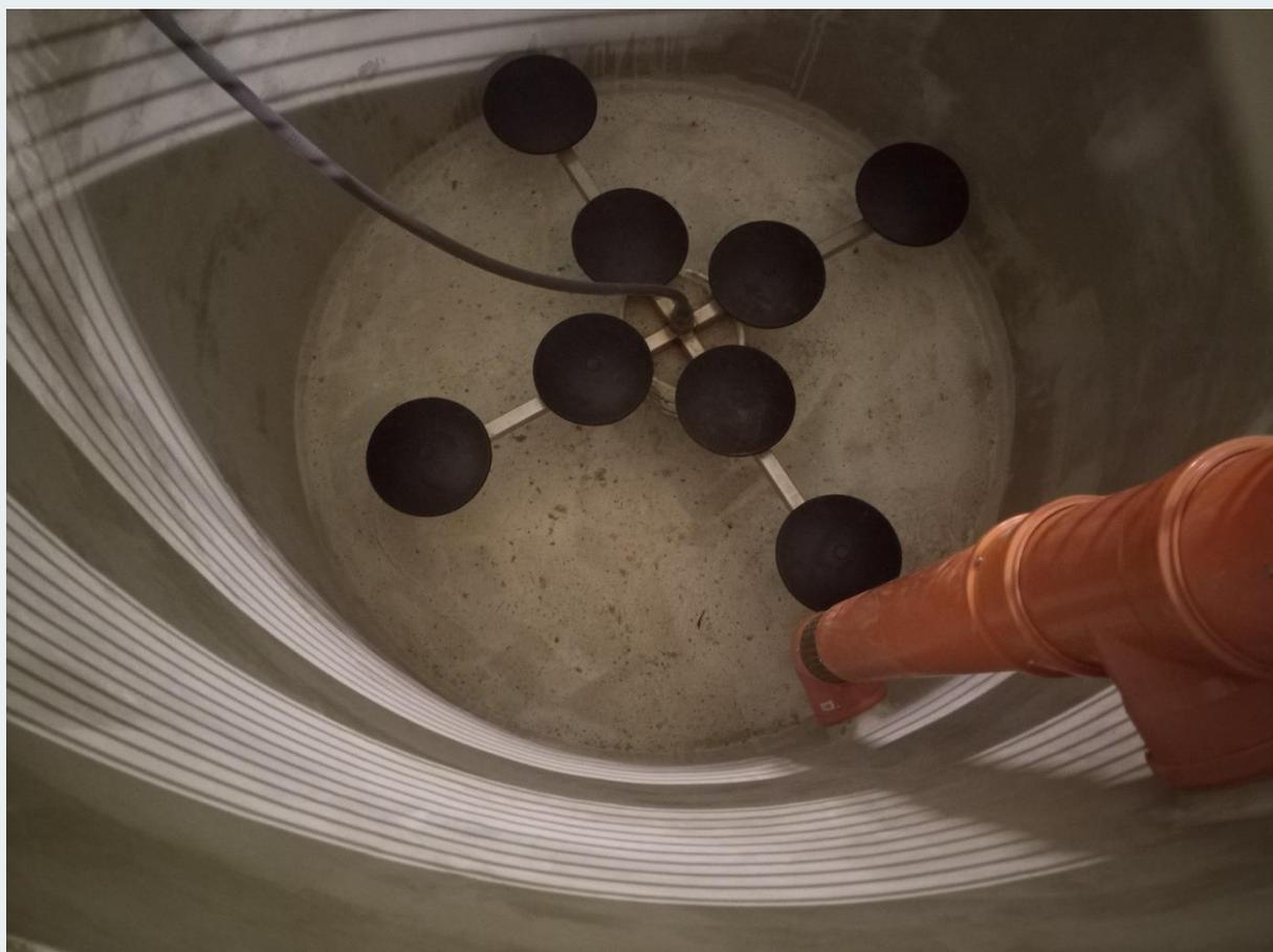
*Рис. 10 Мембранные дисковые диффузоры, установленные в отсеке эрлифта*
