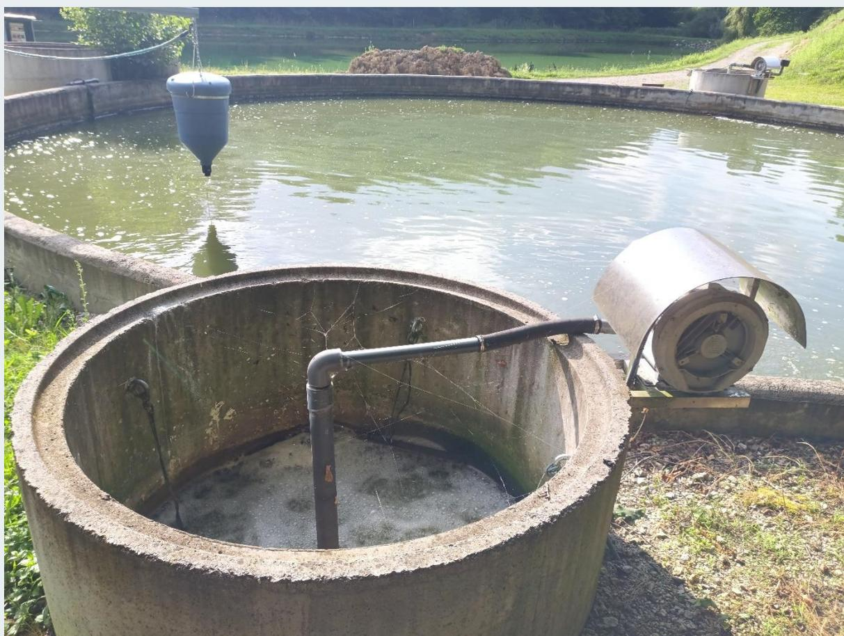
*Рис. 8 Установка вихревых воздуходувок отдельно для каждого эрлифта*
