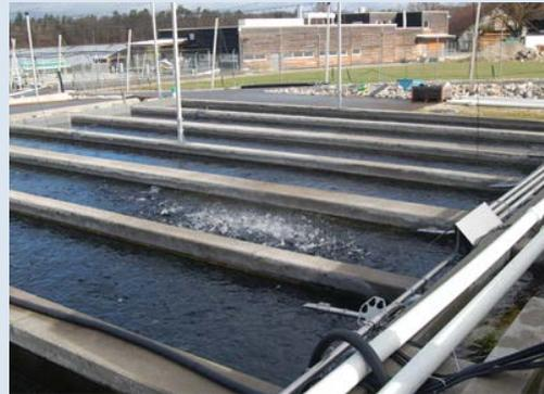
**Jeder Kreislauf verfügt über 20 Mastbecken mit Absetztrichter, einen separaten Trommelfilter und einen Biofilter.**
