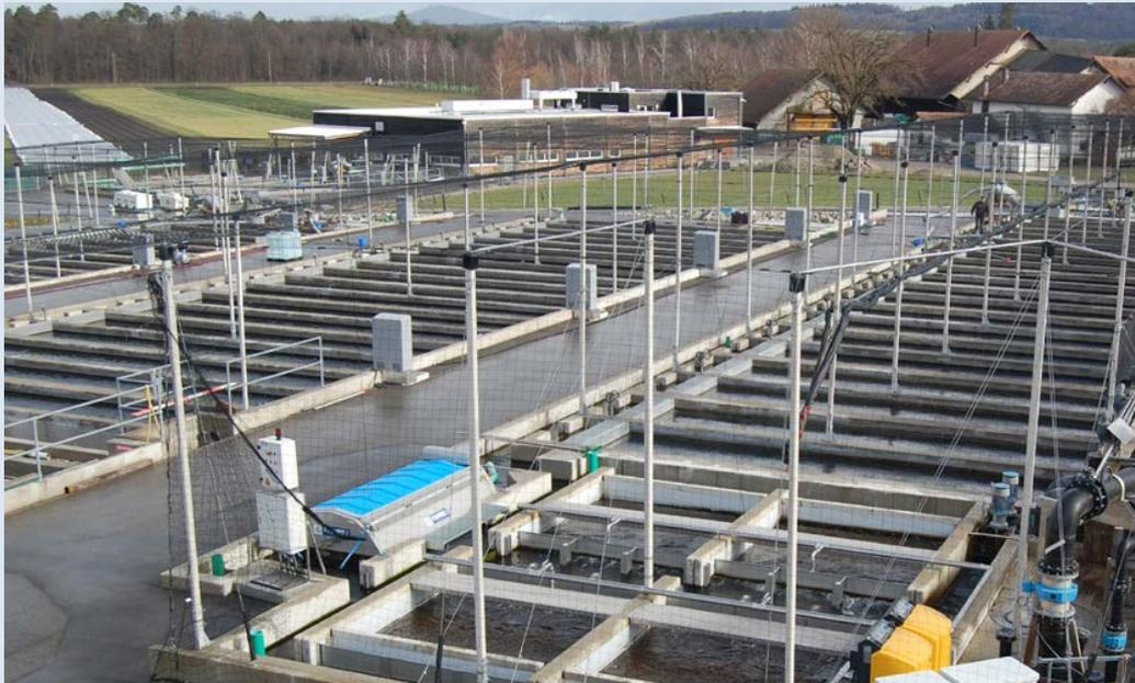
**35-40 l/s Quellwasser speisen ein Bruthaus und drei Teilkreisläufe, durchfließen die Anlage mit ihren 60 Becken und werden dann über eine Reinigungsstufe wieder dem abfließenden Bach zugeführt.**
