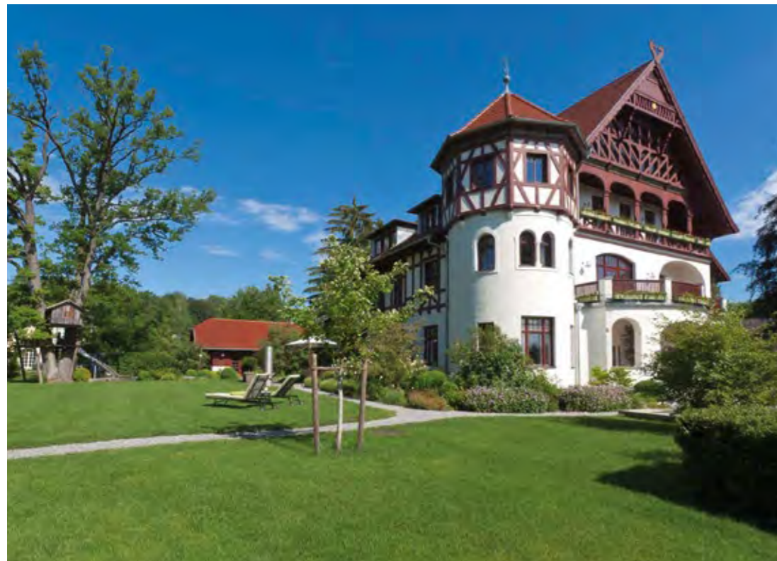
Denkmalgeschütztes Fachwerk-Juwel am Starnberger See.
