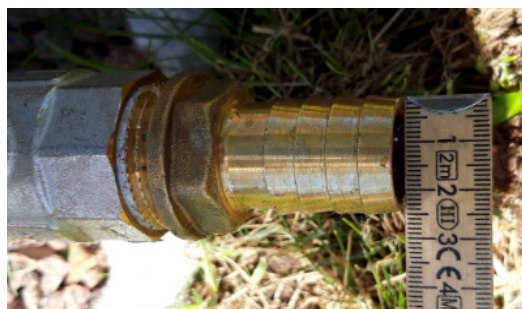
Dimension på avtappningskran är 25 mm.
