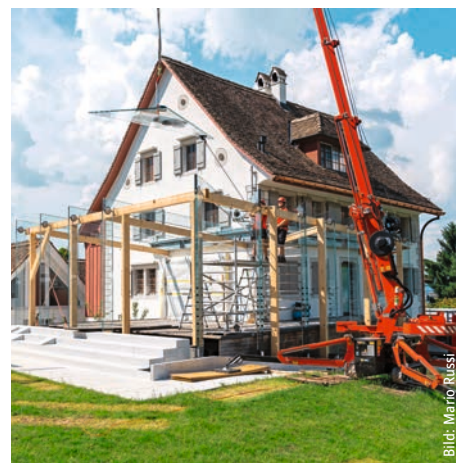
Ein vorgängig erstelltes, präzises Holzgerüst diente als Lehre bei der Glasmontage.
