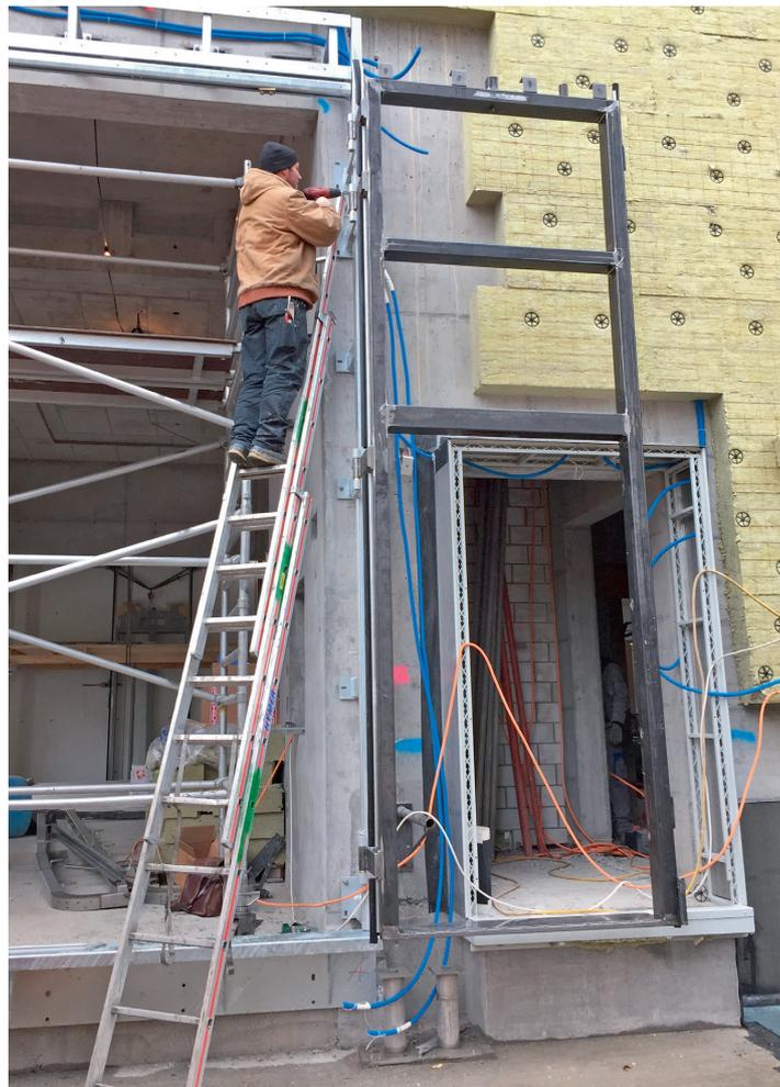
Montage des Grundrahmens. Auch die Flügel sind zu Ausrichtungszwecken provisorisch eingehängt worden.
