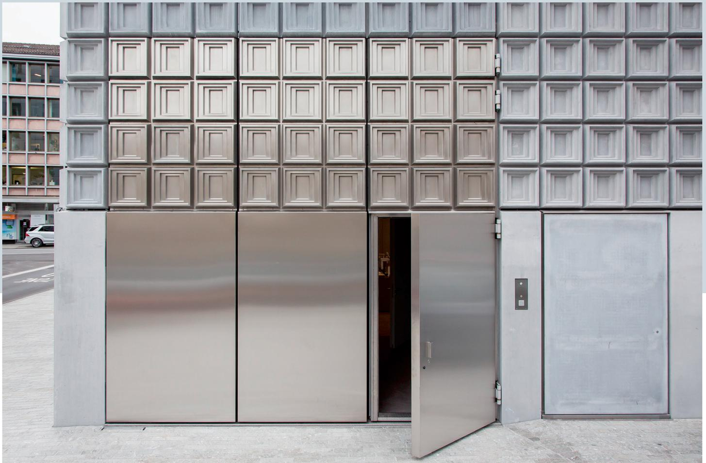
Die rhythmische Anordnung der reliefartigen Quadrate von 487 × 487 mm, wird von der Betonfassade über die Toranlage weitergeführt.
