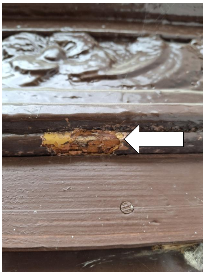
Fot.6. Zbliżenie miejsca w którym wykonano odkrywkę w celu sprawdzenia oryginalnej kolorystyki zachowanego dekoracyjnego nadświetla bramy przy ul. Limanowskiego 24 w Stargardzie, lipiec 2025r., (fot. L. Piotrowska-Cześnik)
