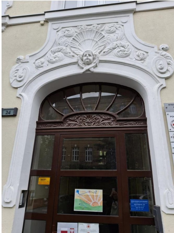
Fot. 1. Zachowane oryginalne nadświetle w bramie wejściowej do kamienicy w Stargardzie przy ul. Limanowskiego 24. Stan w lipcu 2025r. (fot. L. Piotrowska-Cześnik).
