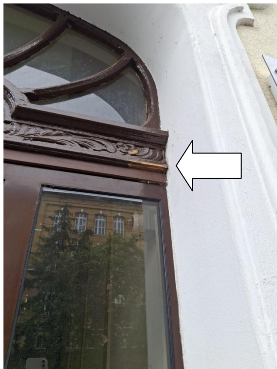
Fot.4. Prawa strona zachowanego nadświetla w bramie do kamienicy przy ul. Limanowskiego w Stargardzie. Strzałką zaznaczono miejsce wytypowane do pobrania próbki do badania stratygrafii warstw farby w celu ustalenia oryginalnej kolory, lipiec 2025r., (fot. L. Piotrowska-Cześnik).
