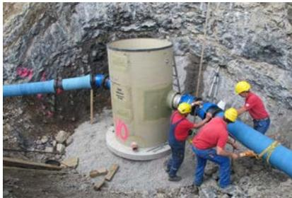
Mitarbeiter eines beauftragten Unternehmens beim Verlegen von Gussrohren der Druckleitung
