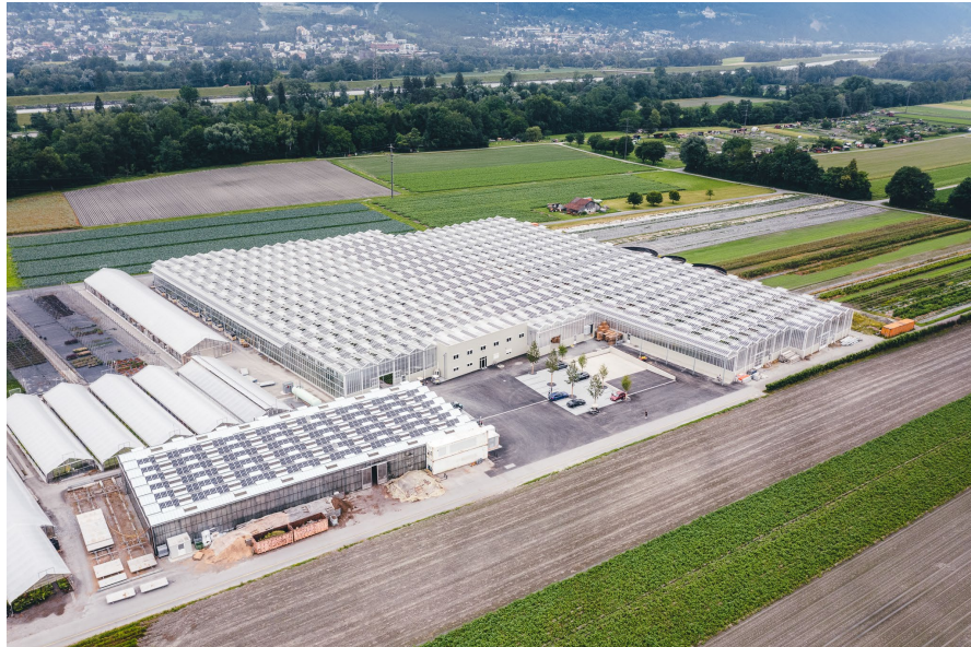
Abbildung 1: Agri-PV Anlage Lubera nach Inbetriebnahme Juni 2024
