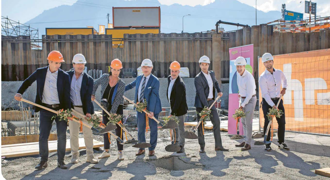
Grundsteinlegung auf dem Areal «Chez Fritz» im Zentrum der Stadt Buchs: Auch der St. Galler Regierungspräsident Beat Tinner (4. von links) und Stadtpräsident Rolf Pfeiffer (5. von links) griffen zur Schaufel.
