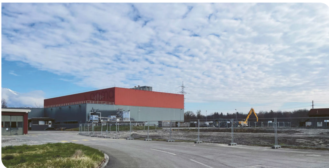
Der Rückbau der ehemaligen ACIMA-Anlagen läuft. Hier soll eine neue Kehrichtverwertungsanlage gebaut werden.
