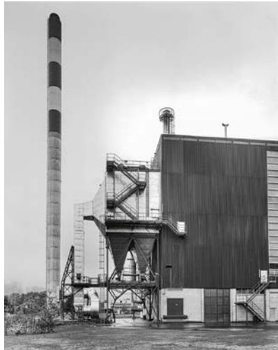
Elektrofilter, Saugzug und Kamin ausserhalb des Kesselhauses.
