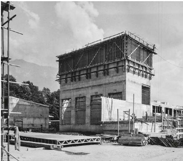
Bau Bunkerbereich inklusive Fundamente Kesselhaus.
