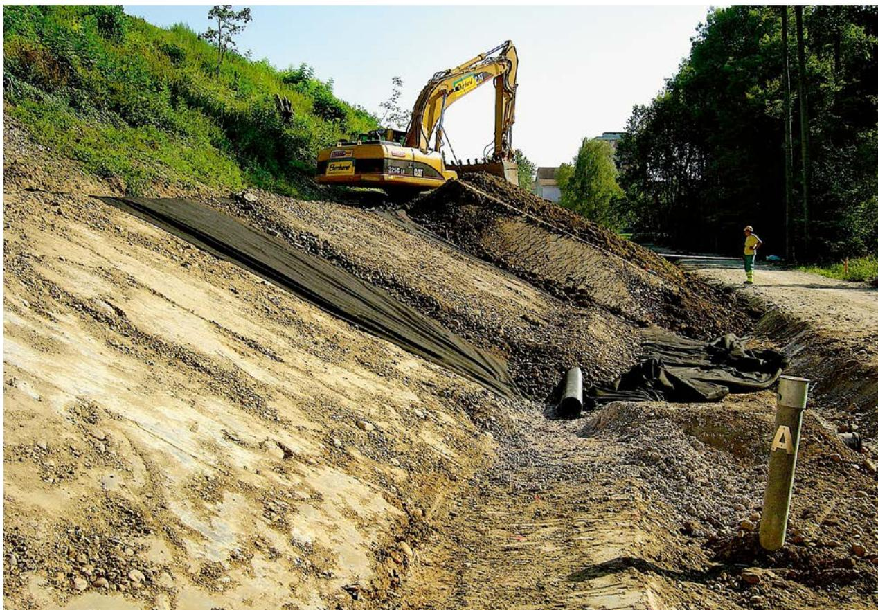
Blick auf den realisierten Schichtaufbau an der Westböschung: Die Planie aus tonhaltigem Dichtungsmaterial (Vordergrund) wird überdeckt mit einer Drainageschicht, darüber folgen Unter- und Oberboden.
