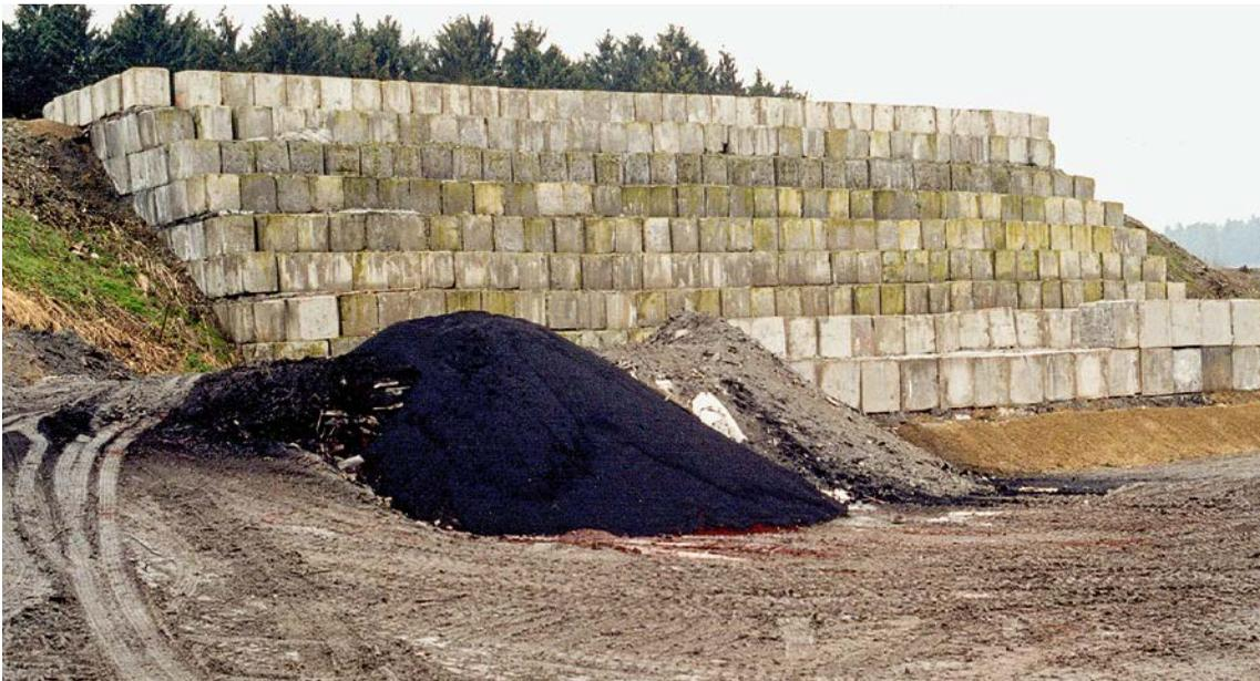
Reststoffdeponie 1999: Versuchsbetrieb mit verfestigten Blöcken aus Rauchgasreinigungsrückständen der KVA Winterthur.
