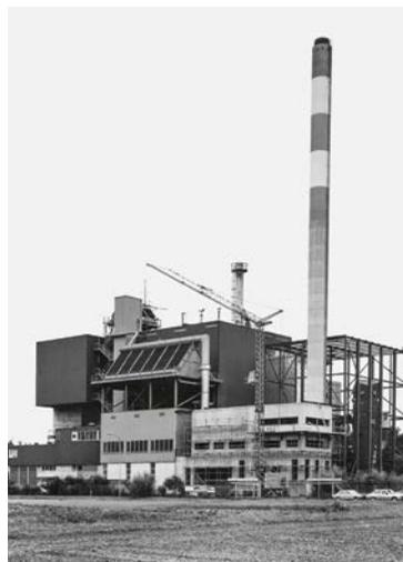
Ofenlinie 1 und 2: Bau der Rauchgasreinigung (Wäscher Von Roll).
