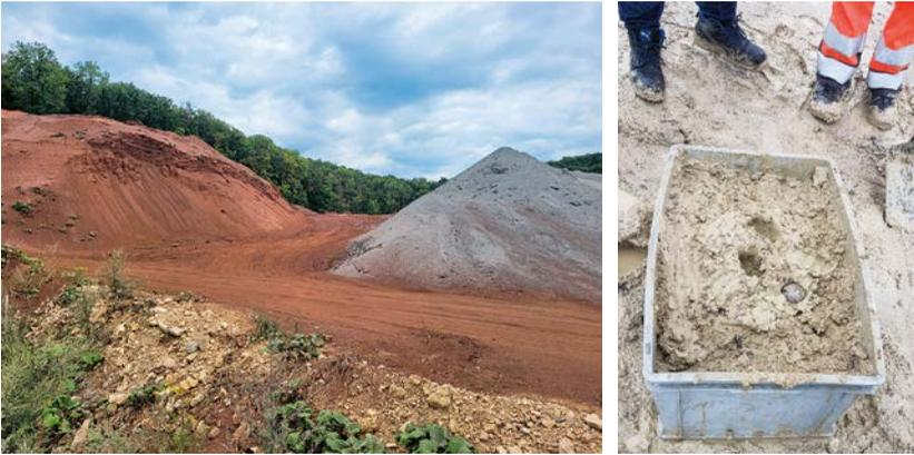
Feinkörniges, strukturloses Deponiegut, das schwer einzubauen ist: Klärslammasche (links) und Aushubmaterial.
