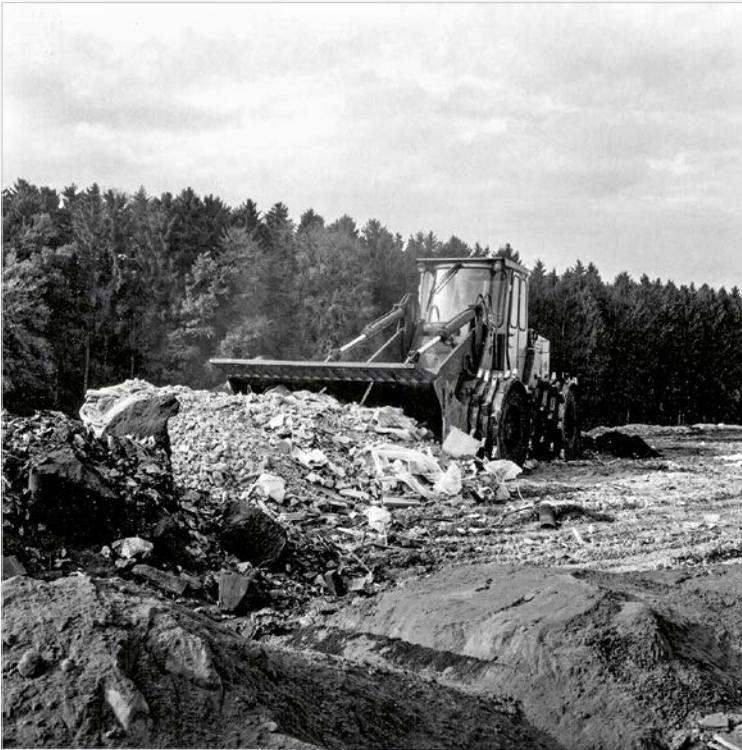
Das Deponiegut wird in Schichten eingebaut und mit diesem 14-Tonnen Spezialverdichtungsgerät (Müllkompaktor) verdichtet. Volumeneinsparung ca. 25 o/o.
