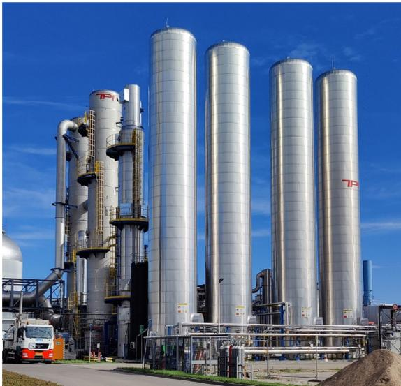
Abbildung 8-9: 300 m<sup>3</sup> CO<sub>2</sub> Speicher AVR Duiven (NL).
