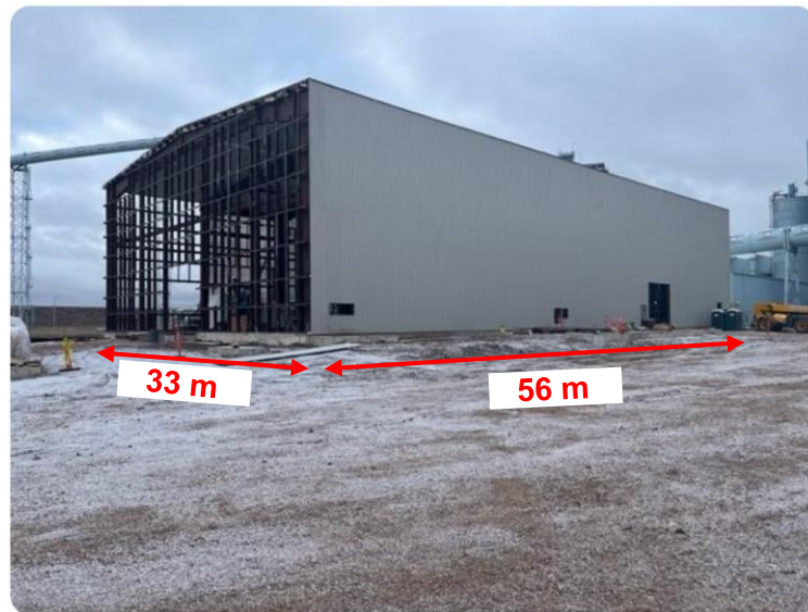
Rohbau Gebäude Membran-Pilotanlage MTR 50 kt CO2 /Jahr
