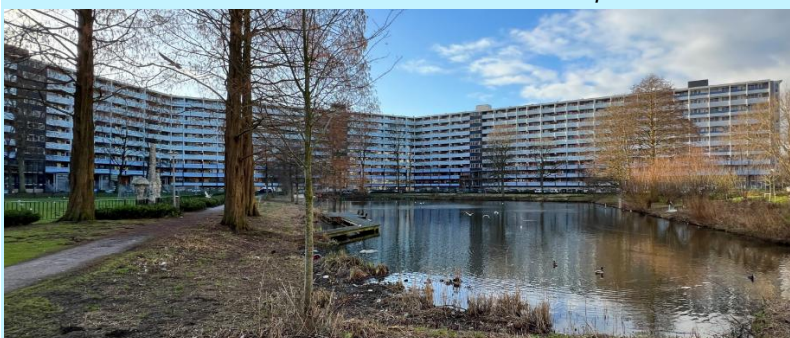
De G-flats voor de renovatie. Beeld: Rochdale/DOOR Architecten
