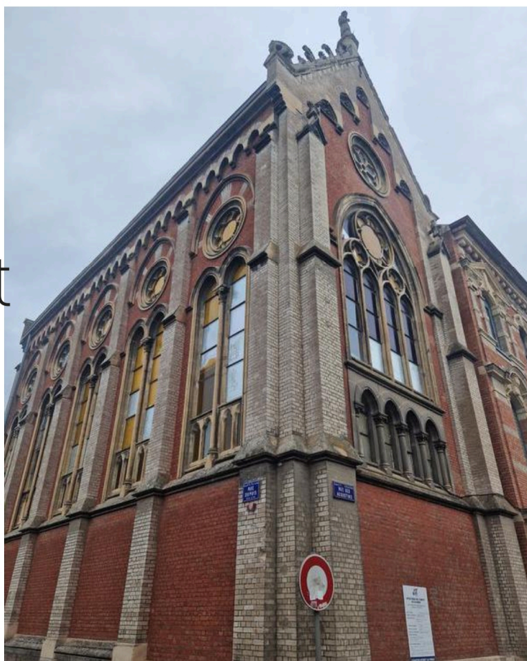
Propriété de l'association L'îlot, la chapelle désacralisée est située à l'angle des rues des Augustins et Dupuis. (PHOTO Bakhiti Zoud)
