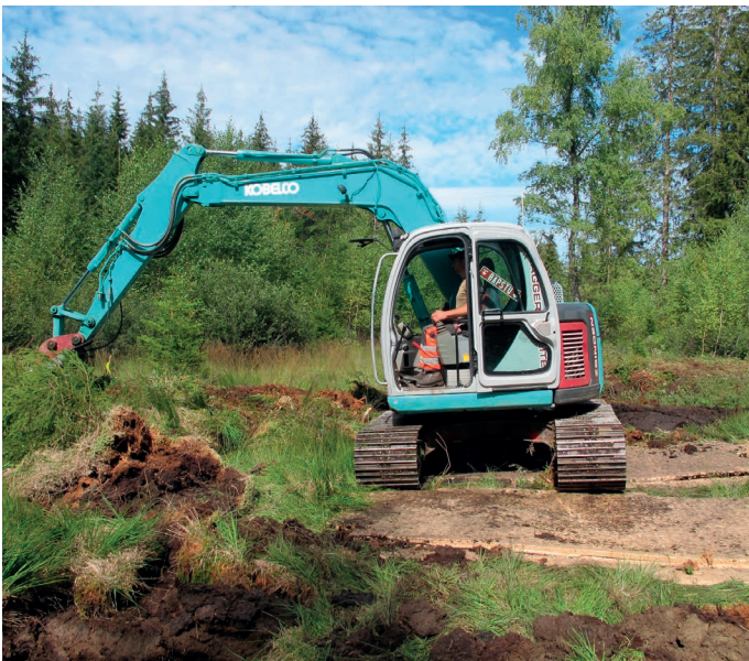
Um die Moorböden bestmöglich zu schonen, wurden leichte Maschinen und zusätzlich Baggermatratzen eingesetzt (Wissenbach, Rüschegg, © Landplan AG).
