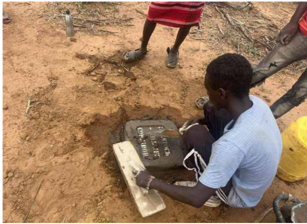
Mitglieder der Gemeinschaft errichten in Oldonyiro einen Korridorfeiler als Teil einer gemeinsamen Standortprüfung – und übersetzen damit kartierte Naturwerte in sichtbare Markierungen, die Umsetzung, Monitoring und den Weg zur formellen Ausweisung unterstützen. Foto: Benjamin Loloju
