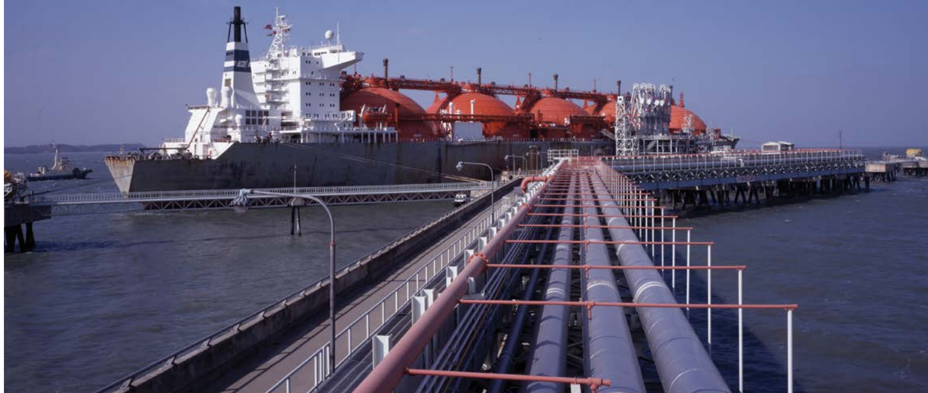
LNG Carrier Pyeongtaek - Courtesy of KOGAS
