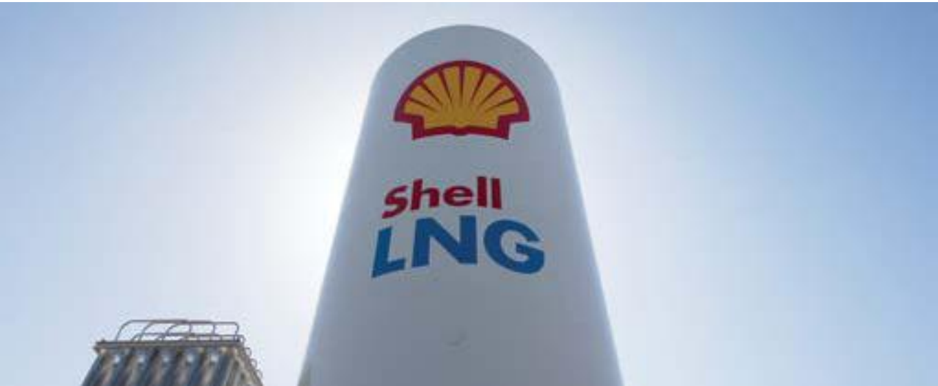
LNG for Transport - Courtesy of Shell
