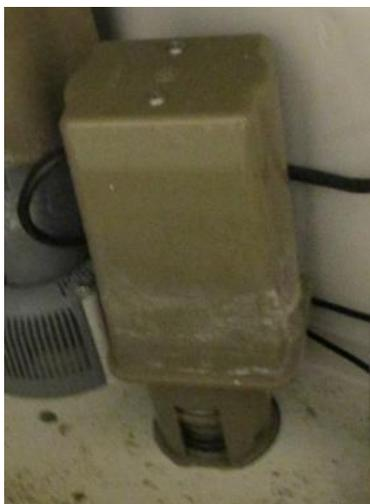
Foto 10 — Valvola di scarico dell'acqua
