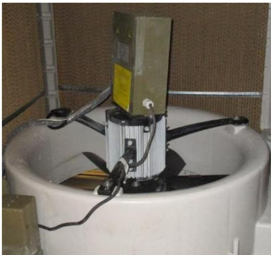
Foto 5 — Motore elettrico dotato di inverter
