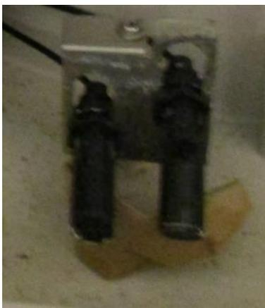
Foto 9 — Sonda di rilevazione del livello dell'acqua
