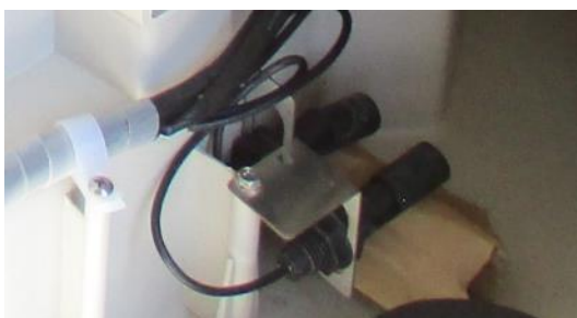
Foto 9 — Sonda di rilevazione del livello dell'acqua
