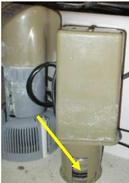
Foto 1 — Valvola per lo scarico dell'acqua
