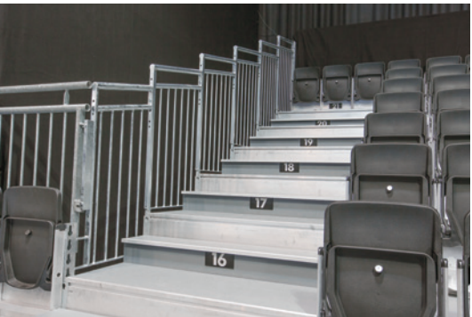
Rutschsichere Beläge, Zwischenstufen mit Kantenschutz und stabile Geländer sorgen für Halt und Sicherheit.
