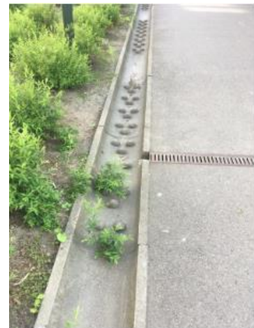
Öppen dagvattenränna i betong längs gångvägen.
