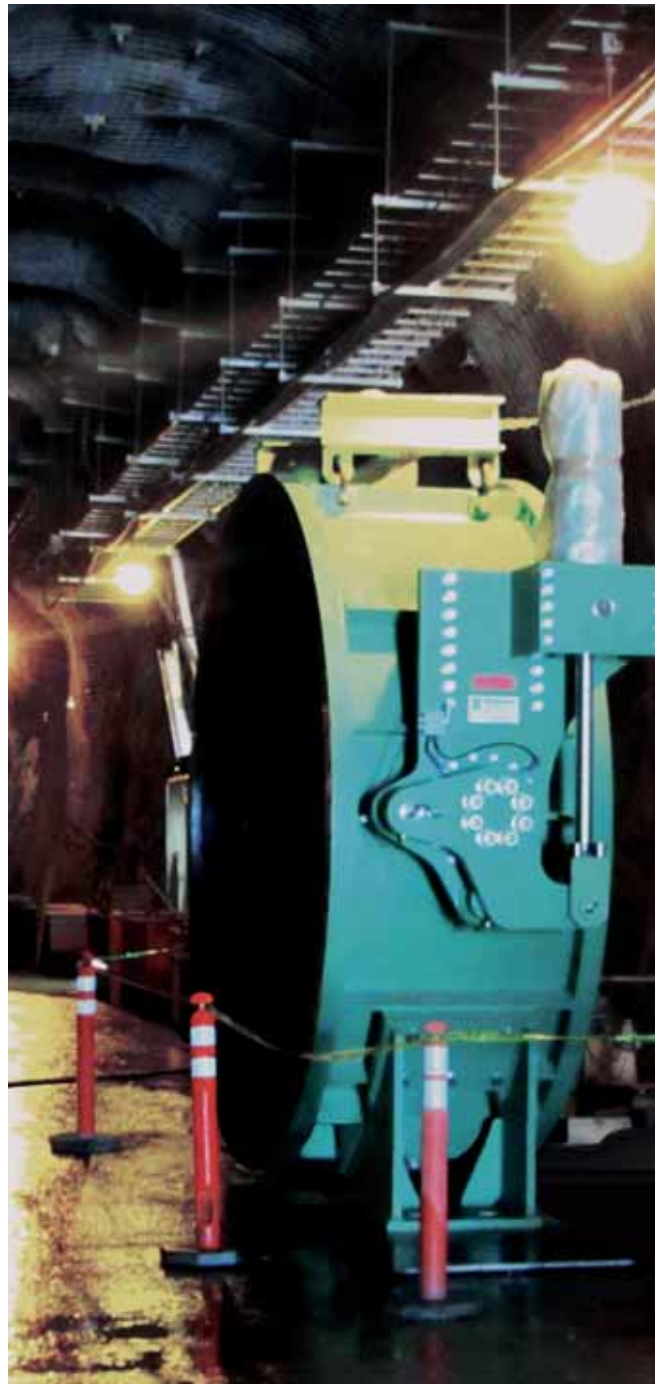
Butterfly valve DN 3350 - PN 8,4 Canada
