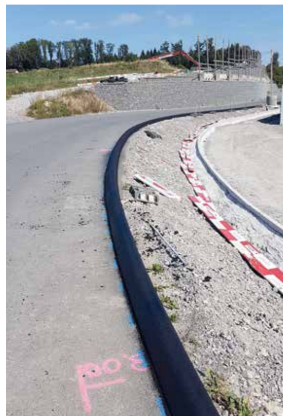
Bituminöser Randabschluss
