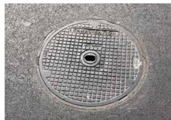
Defekte/Reparierte Schachtdeckelumgebung
