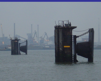
Inspectie van afmeerpalen, Haven van IJmuiden.
