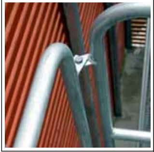
Räckeshörn förbinds med bultförband för maximal stadga.
