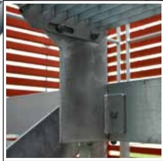
Vid fleröppstrappor kopplas dessa med bultförband mellan plan och vangstycke.
