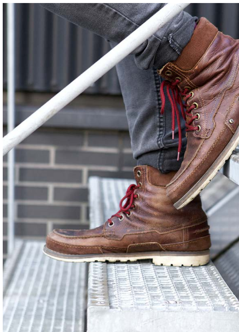
Ovan: Pressdurk vid servicegång. Nedan: Gallerdurksteg med säkerhetsframskant.
