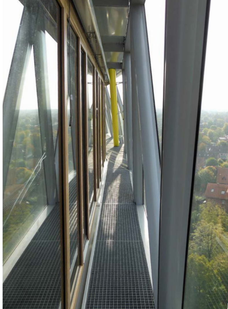
Ovan: Pressdurk vid servicegång. Nedan: Gallerdurksteg med säkerhetsframskant.
