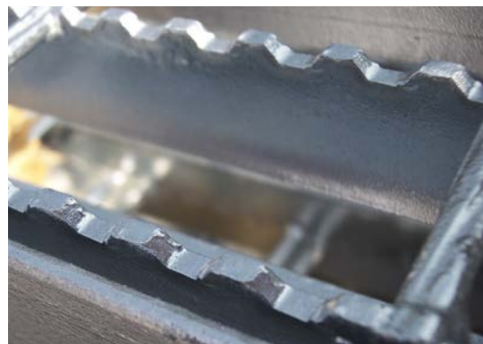
Presssvetsad durk i fyrkantig tandning.
