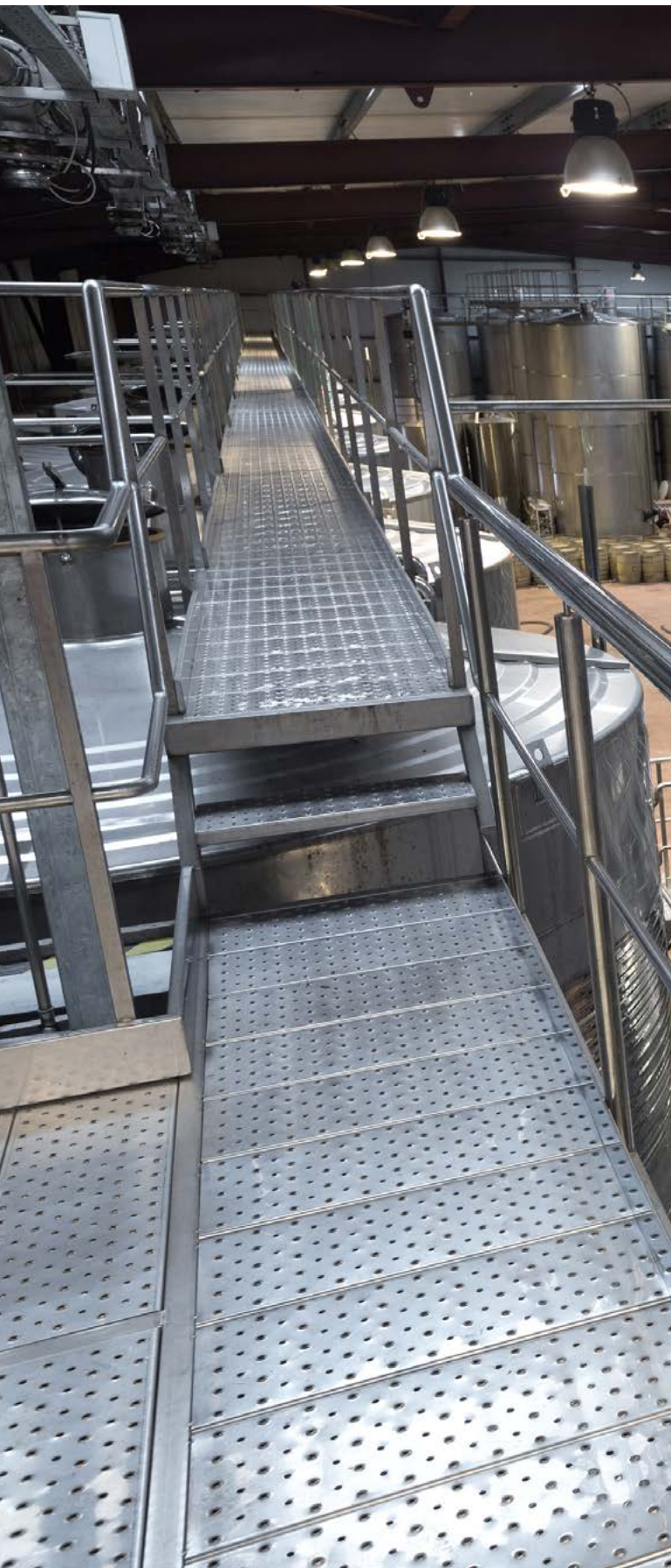
Gångbro av lättduk i industrimiljö.
