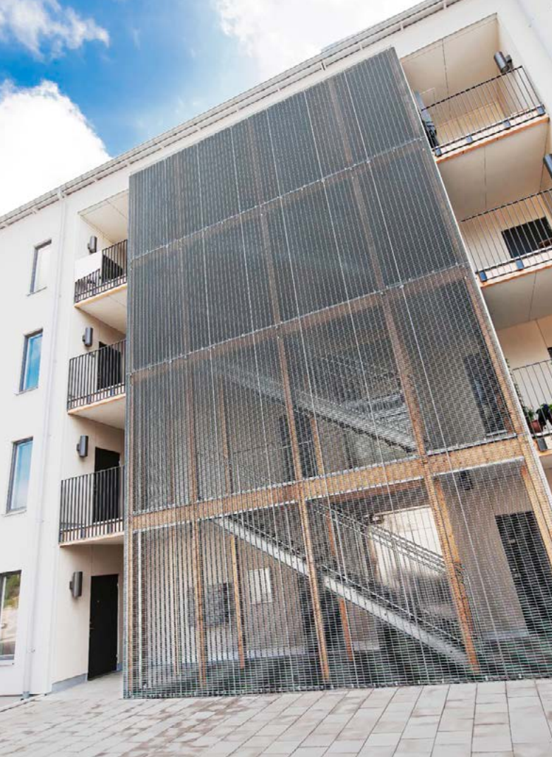
Ovan: Pressvetsdurk som fasadbeklädnad. Nedan: Plattform av gallerdurk.
