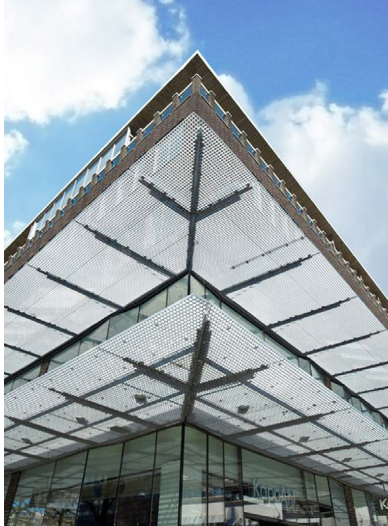
Ovan: Pressdurk som solskydd och tak. Nedan: Fasadbeklädnad i pressdurk för parkeringshus.
