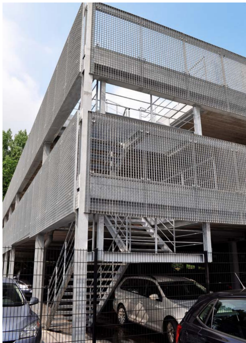
Ovan: Pressdurk som solskydd och tak. Nedan: Fasadbeklädnad i pressdurk för parkeringshus.
