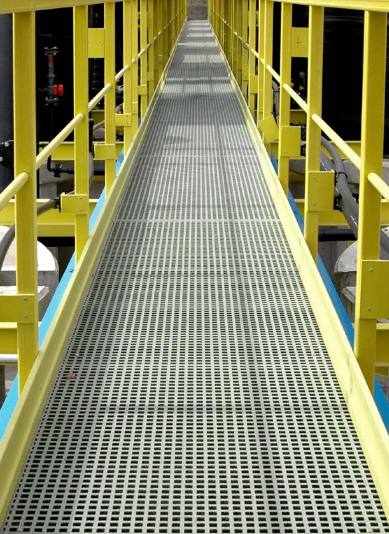
Ovan: GRP durk och räcken till industrigångbro. Nedan: Ränna i pressvetsad durk för smuts- och vattenavrinning.
