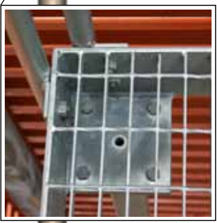
Stödben sitter under planet. Räckena fästs till plan med 2 st M12 bultar vid varje stolpe.
