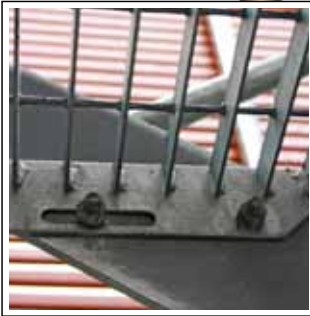
Steginfästning med 4 st M12 bultar i vangstycket.
