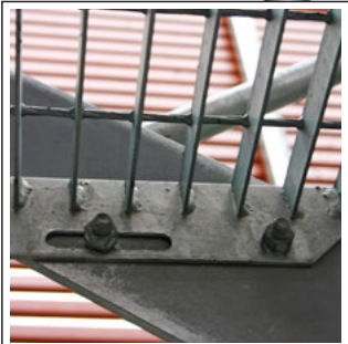
Montering av trinn i vangedelen med 4 M12-bolter.
