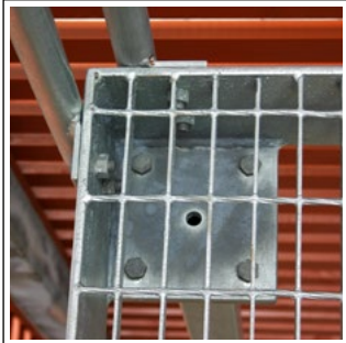
Stottebeinet er plassert under plattformen. Rekkverket er festet til plattformen med 2 M12-bolter ved hver stolpe.
