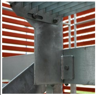
Rettlopstrapper monteres med boltebeslag som forbinder plattformen og vangen.
