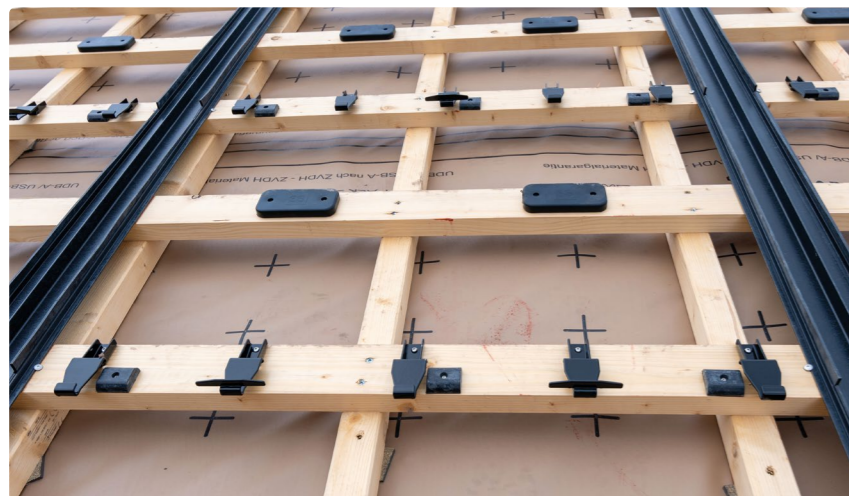
Sottostruttura della soluzione Alpin+ di 3S: cinque ganci in versione Alpin e, in questo caso, due supporti in gomma consentono l'impiego del tetto solare 3S anche in regioni alpine a quote elevate.
